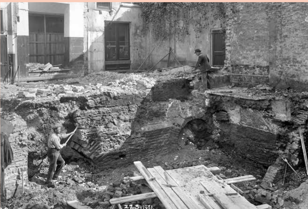
Fundamenten in de Schoonhuissteeg in 1931, voorbereiding voor uitbreiding van de V&D Foto E.A. van Blitz en Zn, HUA 403663
