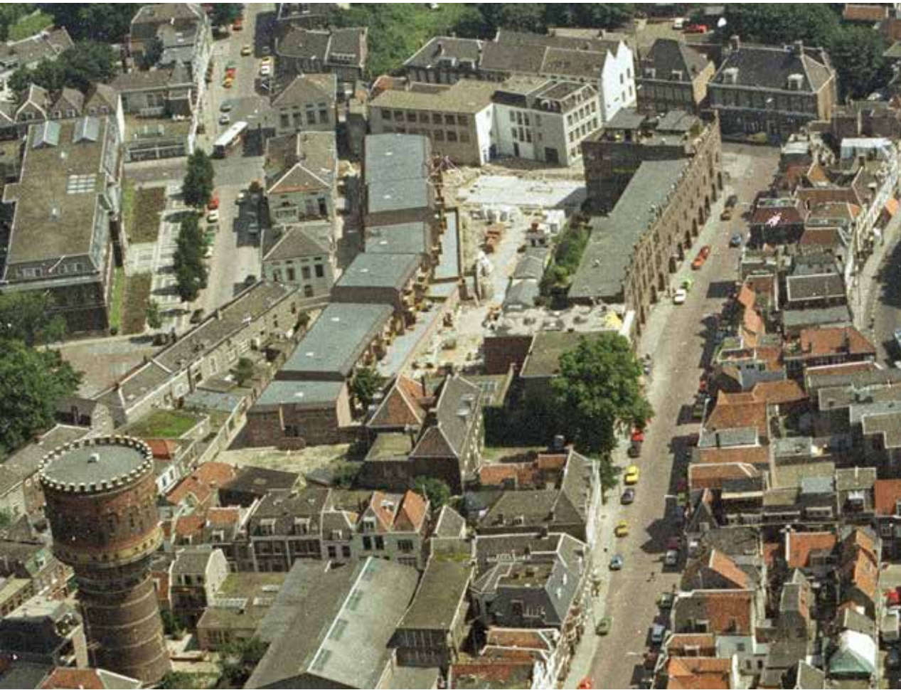
Nieuwbouw Begijnhof in 1980 na sloop van drukkerij
