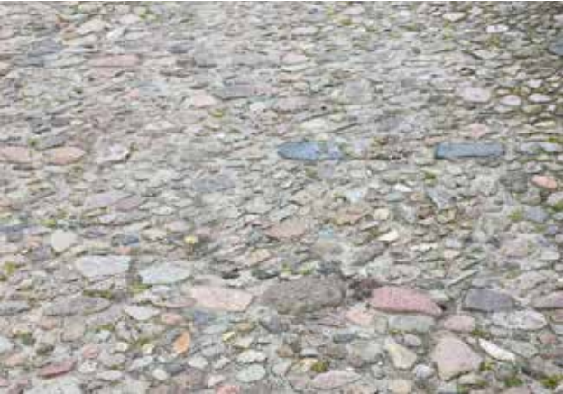
Een keienweg als verharding
