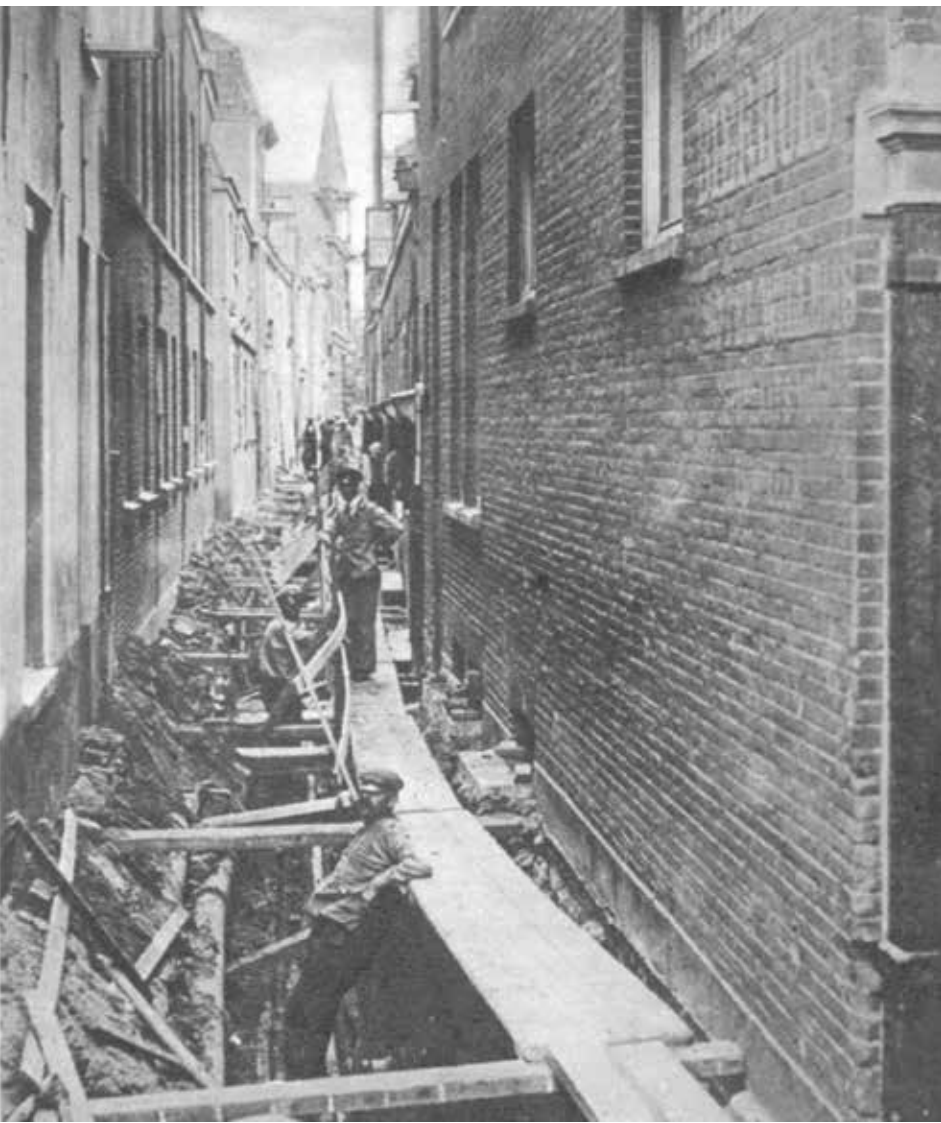
Aanleg van riolering in de Zakkendragerssteeg in 1925 Steeg 74, HUA 74480
