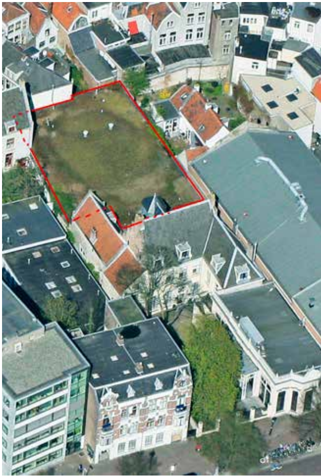
Mariaplaats 14 - luchtfoto achterbouw Sociëteit Luchtfoto uit het vastgestelde bestemmingsplan Mariaplaats 14
