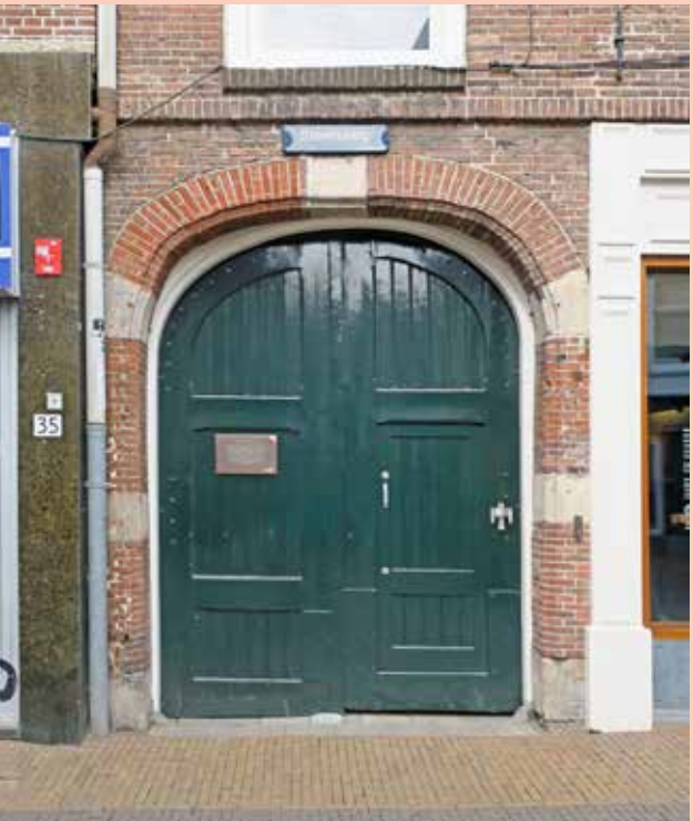
De poort aan de Steenweg naar de achterzijde van voormalig stadskasteel Groot Groenewoude
