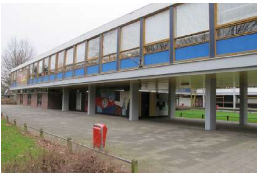
afb. 39 Met pilotis opgezette voorbouw.
