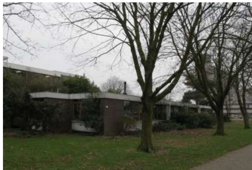
afb. 62 Zuidwestelijke hoekopname van de dubbele woning.
