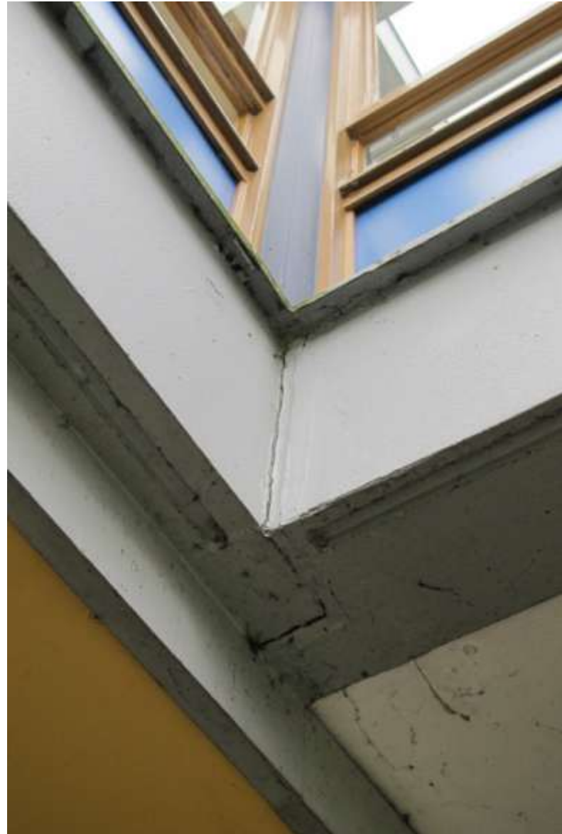
afb. 47 Detailopname met zicht op de constructie van het gebouw.
