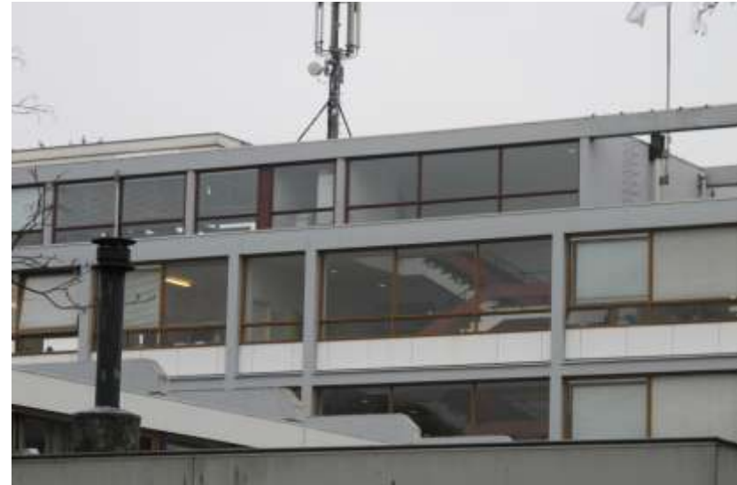
afb. 50 Terugwijkende bouwlaag bovenop de hoofdbouw.
