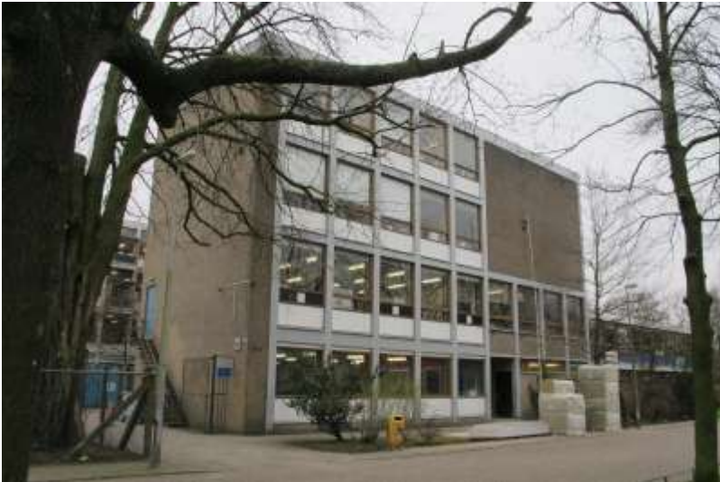
afb. 56 Westelijke kopzijde van de hoofdbouw.
