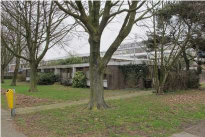
afb. 63 Zuidoostelijke hoek van de dubbele woning.
