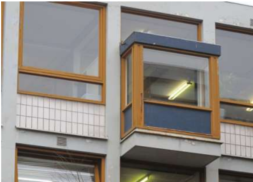
afb. 19 Uitkragende Daltonniss aan de achterzijde van het gebouw.
