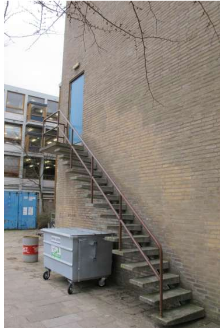
afb. 57 Betonnen trap tegen de meest westelijke achtervleugel.
