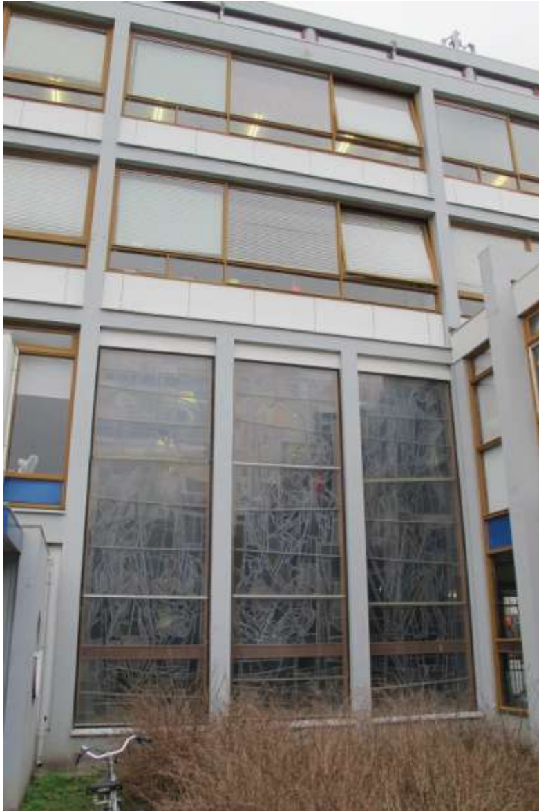
afb. 46 Hoge halvensters met glas-in-lood.
