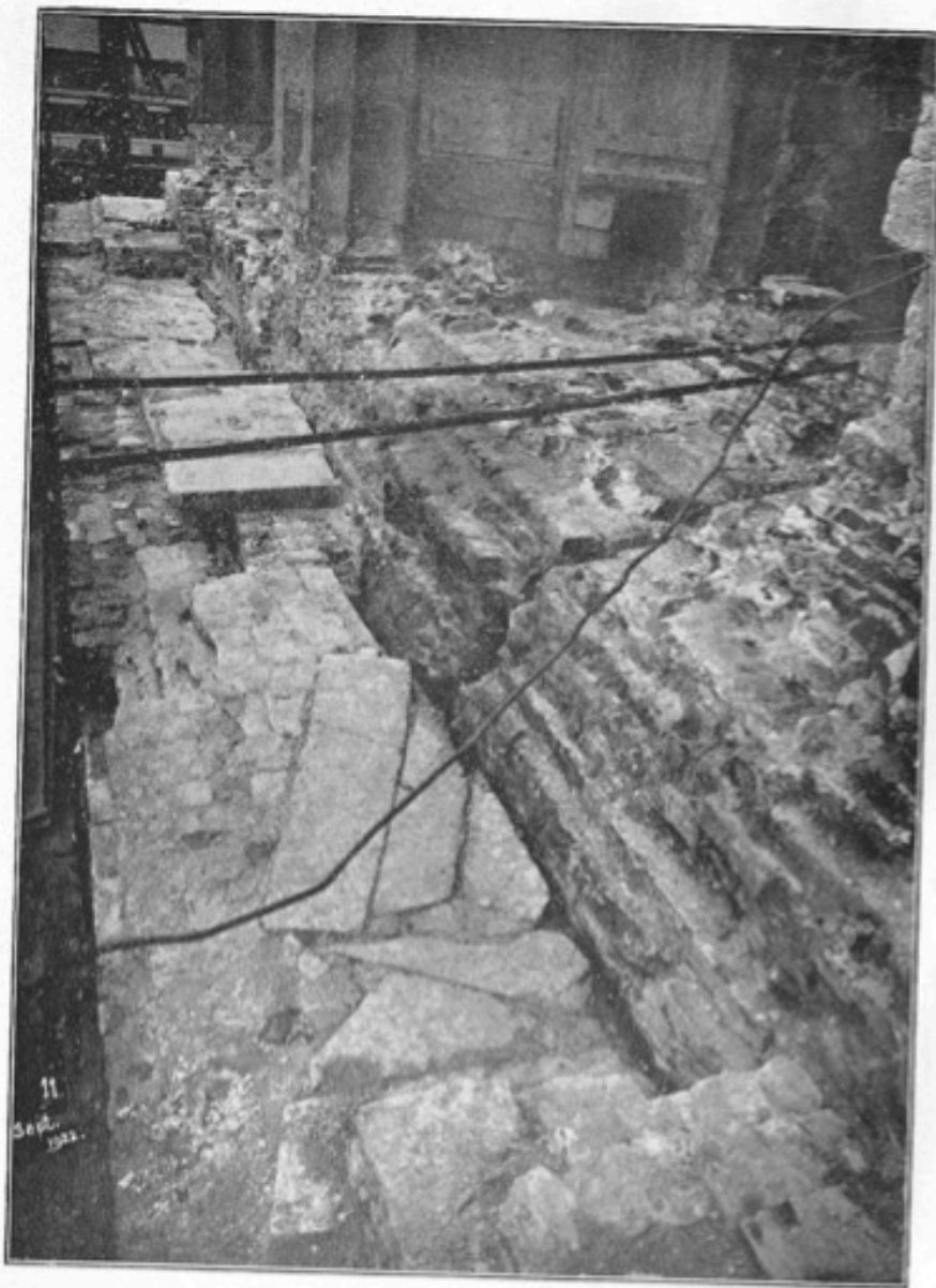
4. Bovenzijde eerste vierkant, noord. Na verwijdering van de bevoering van den omgang: de scheur tus- schen kern en mantel en de scheur in den kern.
