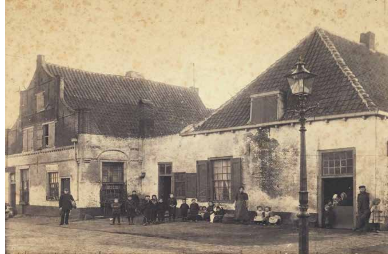
17 e -eeuwse boerderij en pakhuis aan het Sint Janskerkhof, waar in 1794 een loods voor inkwartiering van troepen werd gebouwd. Foto, 1943. Archief Eemland.
