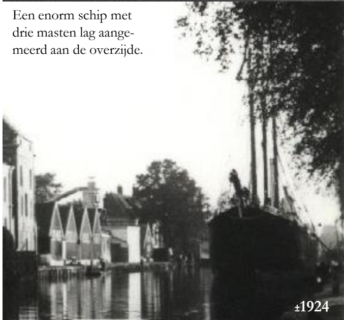
De meubelmakerij bevond zich onder het zaagdak met zoveel gelijkmatig goed licht met alle ramen op het noorden, zodat de elektrische verlichting amper benut hoefde te worden
