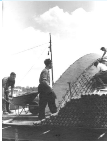
Lokale bouwvakker Huub van Weelde was betrokken bij de aanleg van het nieuwe dak.
