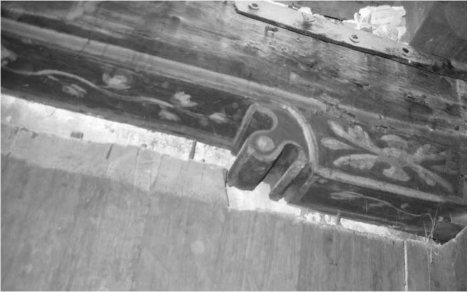
De schildering op de strijkbalk en geprofileerd sleutelstuk (1656-1661) in de opkamer van Rapenburg 67 Leiden. (foto E.D. Orsel)
