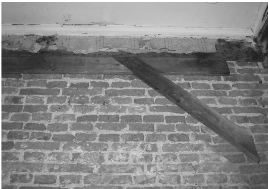
Restant spanraam in de voorkamer van Oude Singel 6 Leiden. (foto E.D. Orsel)
