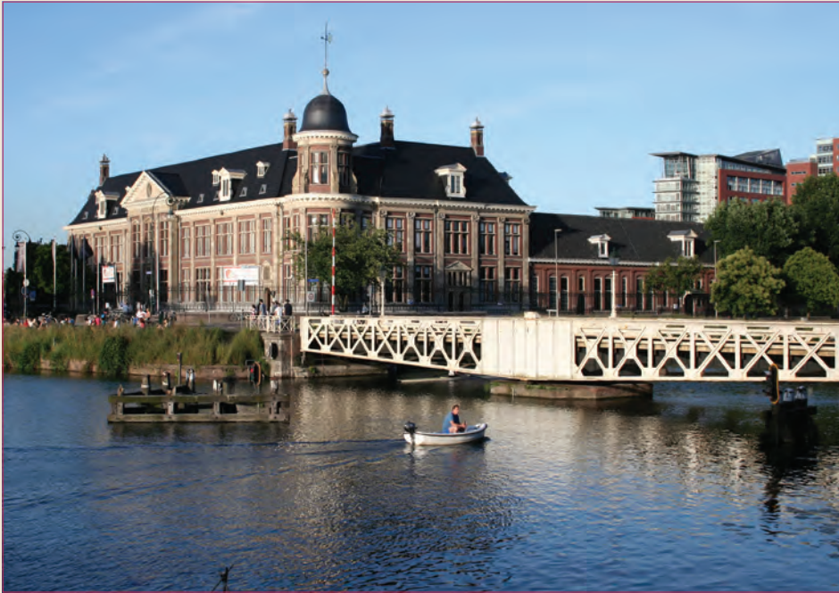
De Muntbrug, de enige nog oorspronkelijke brug over het Merwedekanaal.
