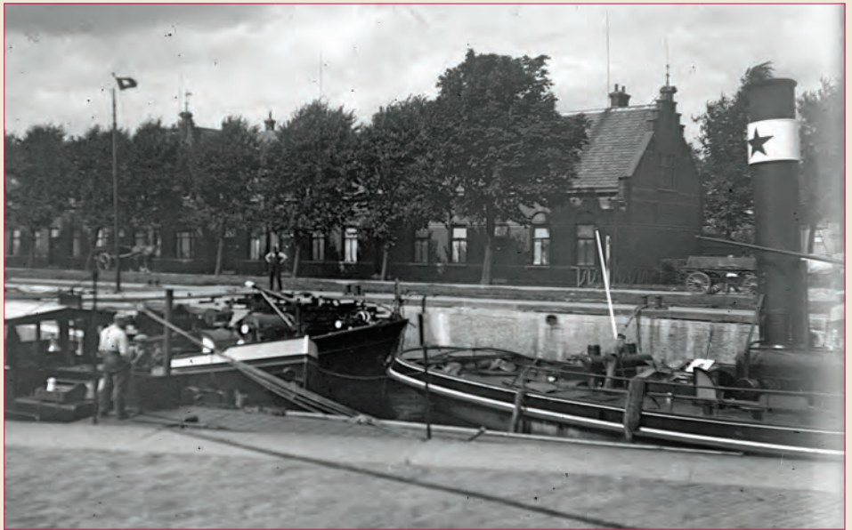
Gezicht op de sluis in het Merwedekanaal te Utrecht, met op de achtergrond de dienstwoningen, ca 1930.
