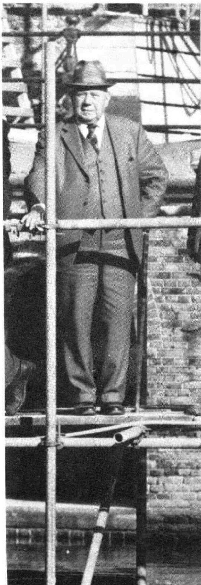
Willem Stoker (86!) op de steigers bij de restauratie van kasteel De Cannenburch te Vaassen. Foto: Paul van Vliet, 1978.
