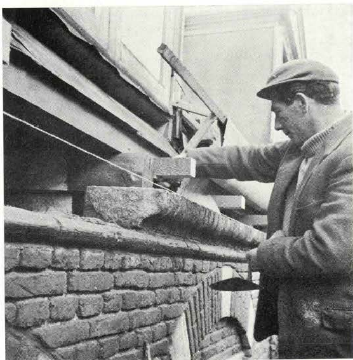
Het restaureren van een van de voor zoveel 17de eeuwse gevels typerende bakstenen lijst, Herenstraat 48 (foto fa. De Groot).
