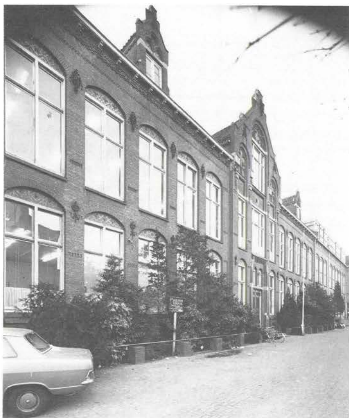
5 februari: voormalige schoolgebouw Lagere Technische School; foto: Fotodienst gemeente Utrecht.
