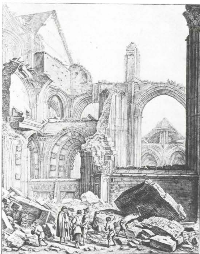
Gezicht uit het noorden op de noordelijke ingang van de Dom na de stormramp van 1674, op de achtergrond de bogen van het half-ingestorte schip; tekening H. Saftleven. (foto GAU, T. A. Hd 22 IV).
