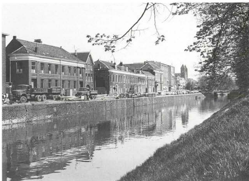
Catharijnesingel/Rijnkade anno 1969. De buizen voor de aanleg van de 'spuikoker' voor de te dempen Catharijnesingel liggen al klaar. Op de achtergrond rechts is de nieuwbouw van de SHV zichtbaar, met daarachter de torens van de Gertrudiskerk. (Foto Dienst Gemeente Utrecht)
