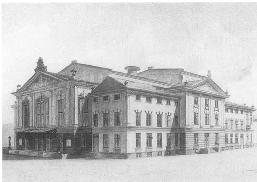
De schouwburg na de verbouwing. GAU, TA X 4.19, neg. C34.248
