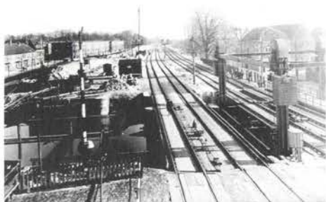
Rechts de hulpbrug over de Vaartsche Rijn, in het midden de draaibrug in de spoorlijn naar Arnhem, links daarvan zijn de voorbereidingen begonnen voor de ophoging van de sporen naar Arnhem. Uiterst links de huizen aan de Pelikaanstraat. Situatie januari 1937. HUA, Coll. Beeldmateriaal, 153586.
