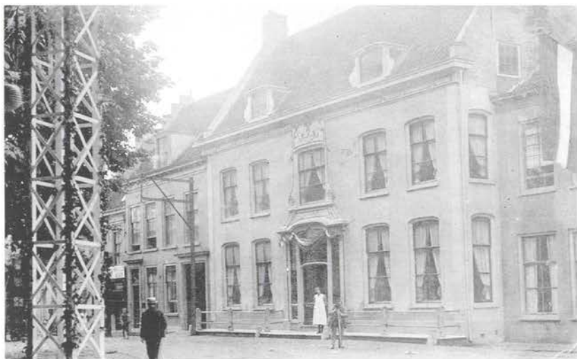
Deel van het gebouwencomplex De Nederhof aan de Markt waarin de wijnhandel Tellegen & Pels was gevestigd op een foto uit 1919, SAKRUH, Collectie en archief J.A.F. Thieme.
