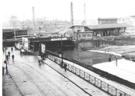
Rechts: Eerste (westelijke) deel Leidseveertunnel in aanbouw, 1937. De keermuren, steunmuren en tunnelvloer zijn gereed; op de achtergrond de perronkap van het Buurtstation. Foto Verz. NVBS.
