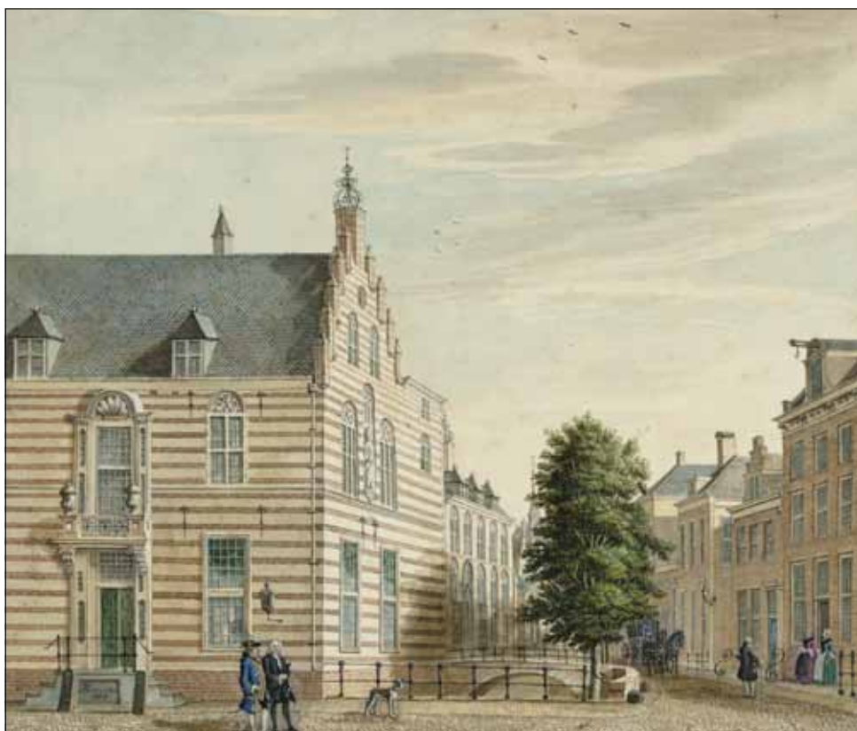
De Kromme Nieuwegracht gezien vanaf de Pausdam. Links Paushuize waar de graaf van Sinzendorf, gevolmachtigde van de keizer, verbleef. Aan de overkant staat Nieuwegracht 80 dat de Hollandse gevolmachtigden Buys en Van der Dussen in onderhuur hadden van Johan de Marez. J. de Beijer 1765, naar een ouder voorbeeld. HUA, Collectie Beeldmateriaal, nr. 30216.
