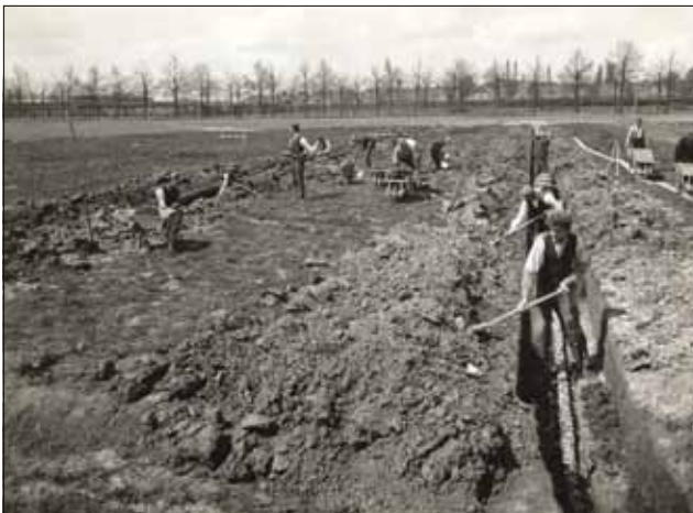
Het graven van een drainagesleuf door werkloze jongeren. Foto Jochmann Disco, 1935. HUA, Collectie Beeldmateriaal, 42336.
