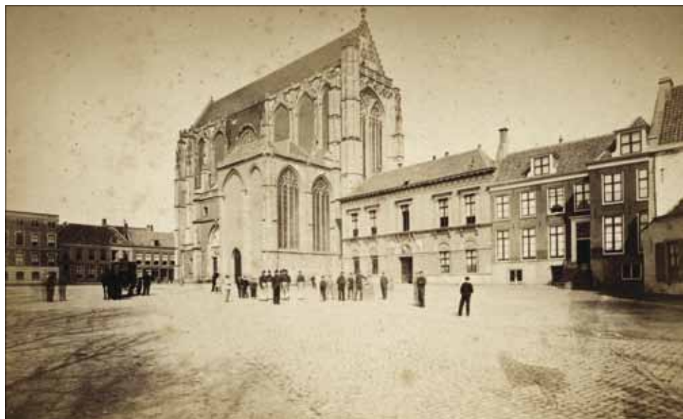
Een goede indruk van het ruime maar stille Munsterkerkhof, ons huidige Domplein, geeft deze foto van P. Oosterhuis uit circa 1870. Het Leesmuseum speelde een belangrijke rol in de oostelijke pleinwand. Het Utrechts Archief, Beeldmateriaal, nr. 122361.
