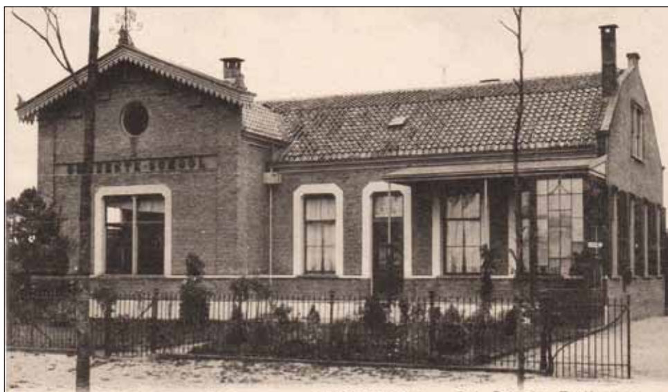
De lagere school in Maarsbergen, gebouwd in 1862/1863. Ansichtkaart omstreeks 1905, Uitgeverij Nauta, Velzen. Particuliere collectie.
