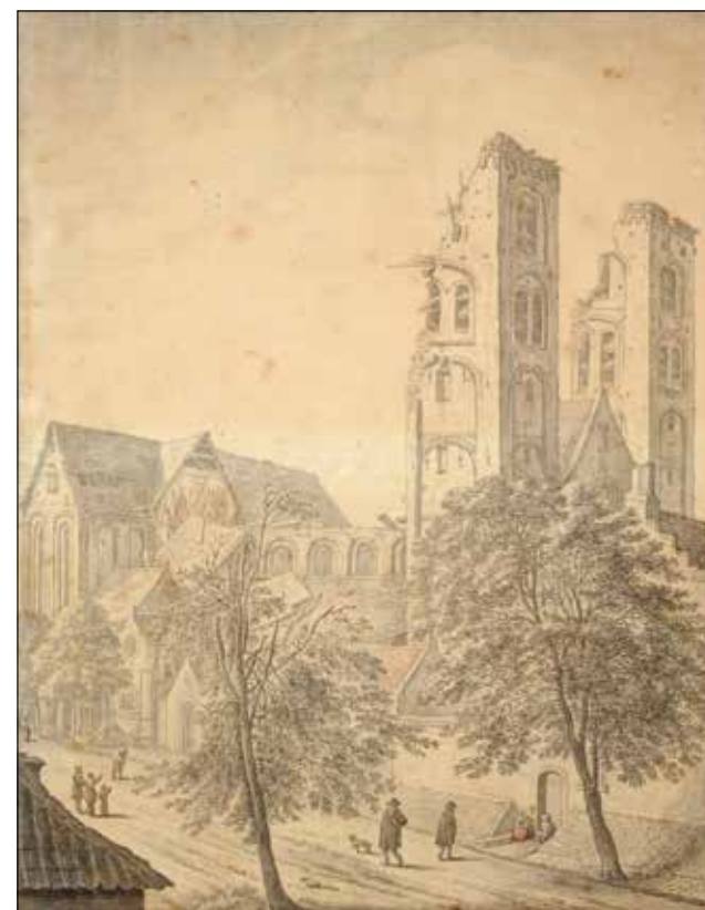
4 De Pieterskerk na de storm, met duidelijk zichtbaar de afgebroken torenspitsen die door het dak van de kerk gevallen zijn. Tekening van Herman Saftleven. Het Utrechts Archief.
