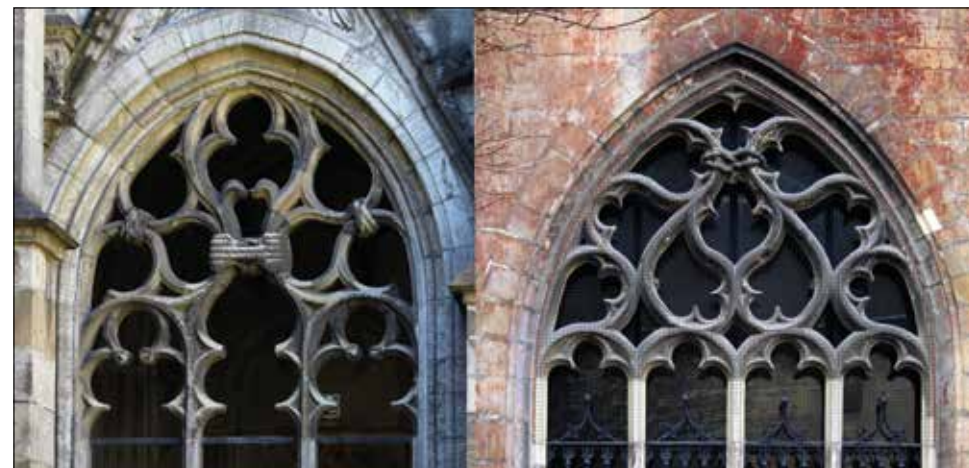
8 Tracteringen in de kruisgang van de Dom in Utrecht (links) en in die van Sint-Servaas in Maastricht (rechts). In beide gevallen zijn onderdelen met elkaar verbonden door middel van een stenen touw. Foto auteur.
