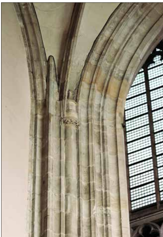
18 Transeptpijler op de grens van de twee zuidelijke zijbeuken van de Dom in Utrecht vanuit het zuidwesten: door de planwijziging sluit de versmalde (en na 1674 dichtgezette) scheiboog links niet goed aan op de pijler: een van de profielribben verdwijnt in het gewelf. Foto auteur.
