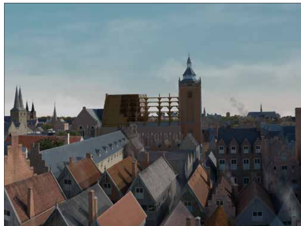
6 Ook de kap van de Buurkerk werd door de storm verwoest. Hier een reconstructie van de Buurkerk tijdens de bouw van de grote kap in 1441. Afbeelding Daan Claessen, Erfgoed gemeente Utrecht.
