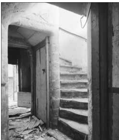
22 Opgang van één van de trappen van de dubbele trap in het voormalige Elisabethgasthuis in Utrecht, vlak voor de ontmanteling in 1965. De tweede opgang bevindt zich links in de doorgang. RCE, objectnummer 84.582.
