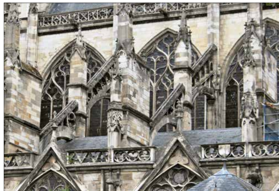
17 Lichtbogen aan het vijfbeukige schip van de kathedraal van Troyes (tweede helft vijftiende eeuw). Ze zijn over beide zijbeuken geslagen met een steunpijler boven de zijbeukpijlers. Foto auteur.
