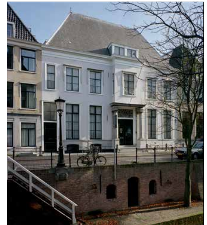
De voorgevel en werfkelder van het huis Nieuwegracht 6 in 1996. Fotodienst GAU, HUA, Collectie beeldmateriaal, 117106.
