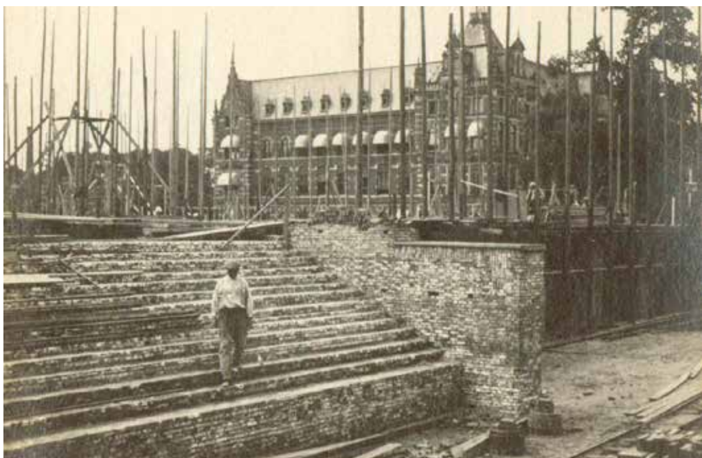
Het Derde Administratiegebouw van de spoorwegen aan het Moreelsepark in aanbouw, 8 juni 1919. HUA, Beeldmateriaal 86264.
