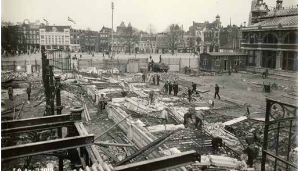
Deze foto van een deel van het Vreburg, Utrecht is genomen op 30 april 1919, de dag voordat het maandcontract van Spyglass in Hotel De l'Europe begon. Op de voorgrond zijn slopers bezig ruimte te maken voor het eerste permanente Jaarbeursgebouw. Het hoge witte gebouw op de achtergrond is Hotel De l'Europe. De vlaggen wapperen ter ere van de verjaardag van Prinses Juliana. Foto: F. Moesman. HUA, Beeldbank, cat. nr. 403155.
