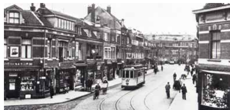
De Damstraat met de bocht naar de Kanaalstraat. Op de achtergrond de gevel van de Sypensteinkazerne.
