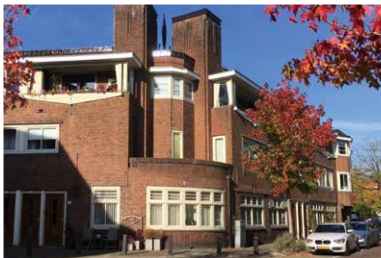
De hoek van het woningcomplex van Woningbouwvereniging Utrecht aan de Paulus Potterstraat (links) en de Hobbemastraat met voor deze bouw kenmerkende onderdelen, zoals de inpandige balkons omlijst met afgeschuinde, in een lichte kleur geschilderde planken. Deze hoek van het gebouw wordt geaccentueerd door twee blokvormige torens met daartussen een object van siersmeedwerk. Bij de laatste restauratie zijn langs alle dakranden de verticaal geplaatste verglaasde tegels opnieuw aangebracht. Foto auteur, 2018.
