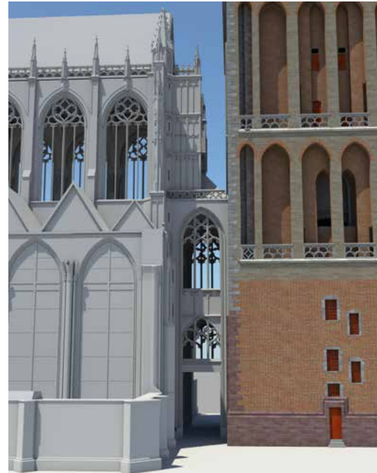
De Domtoren was als losstaande toren ontworpen, maar in 1484 werd er een brugkapel gebouwd die de toren op 11 meter hoogte zou gaan verbinden met het toen nog te bouwen schip. Reconstructie Daan Claessen en Frans Kipp, Erfgoed gemeente Utrecht.
