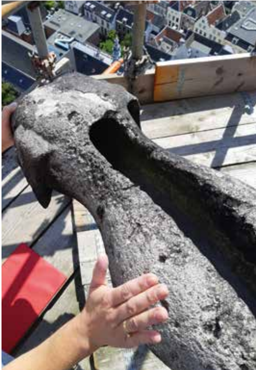
In de Domtoren zijn nog sporen uit de lange geschiedenis terug te vinden, zoals deze spuwer van trachiet die nog uit de bouwtijd dateert. Foto René de Kam 2019.
