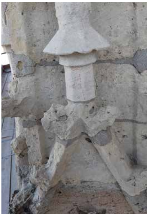
In de lantaarn van de Domtoren is nog steeds natuursteen terug te vinden die waarschijnlijk uit de bouwtijd dateert, al is het soms wel erg door regen en wind gesleten. Foto René de Kam 2019.
