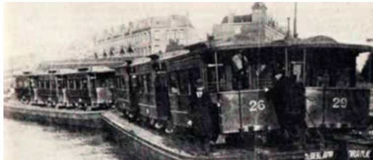
Wittevrouwenbrug, ter hoogte van de voormalige Gasfabriek.
