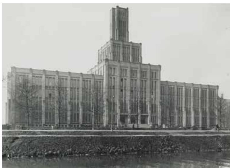
Hoofdadministratiegebouw Spoorwegen kort na oplevering, 1921. Spoorwegmuseum, Spoorwegen in Beeld 9052.
