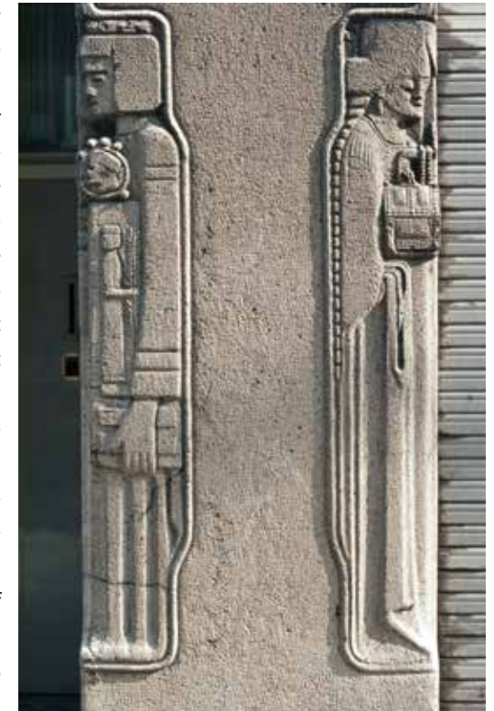
Detail voorgevel Oudkerkhof
