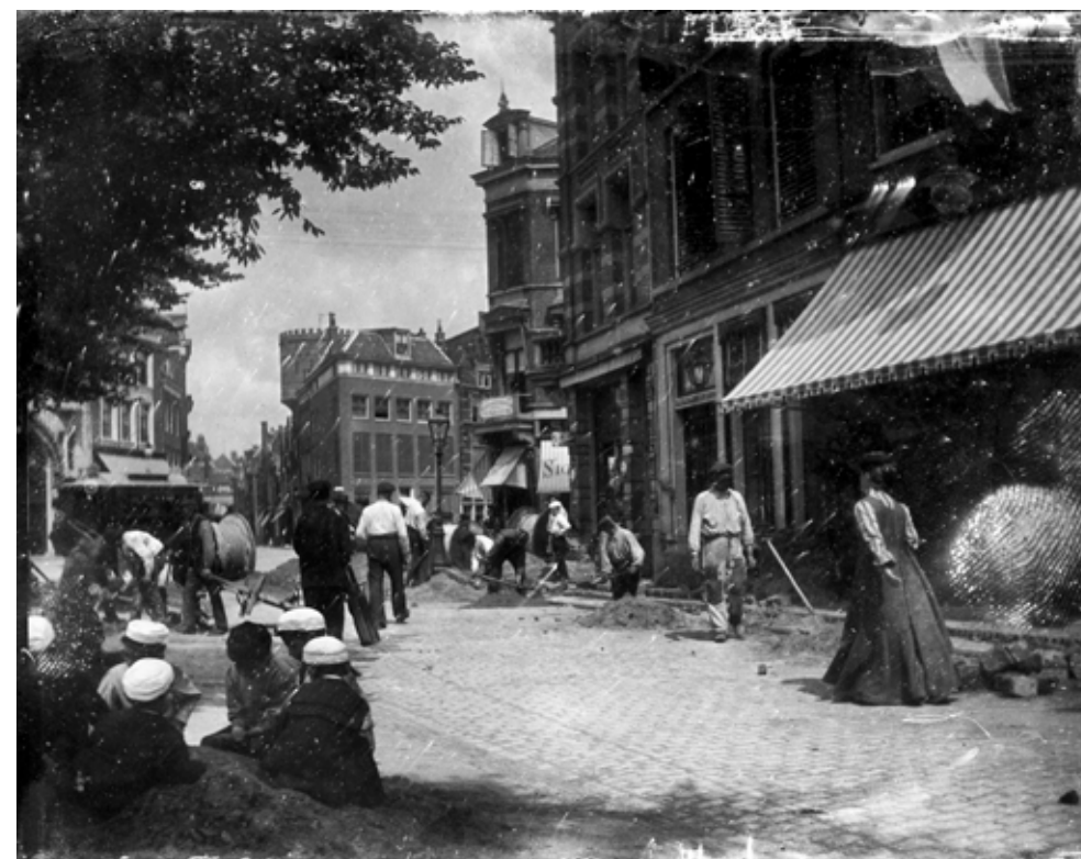
Graafwerkzaamheden voor elektriciteitskabels, hier aan de oostkant van de Neude omstreeks 1905, een bron van inspiratie voor Van Laar. Collectie Het Utrechts Archief, cat.nr. 64578. Foto Joh. A. Moesman.
