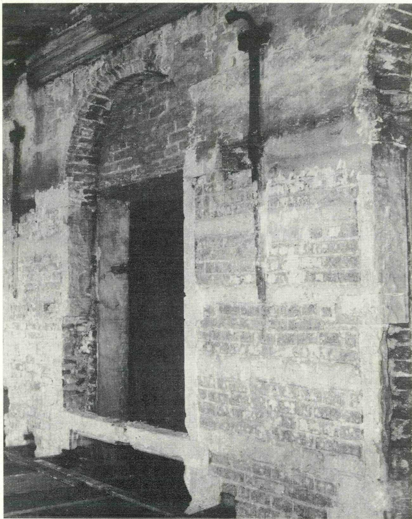
Een van de vroegere vensters van Paushuize (oostzijde, binnenplaatsgevel). Van het oorspronkelijke natuurstenen kruiskozijn is het kalf bewaard gebleven. De onderste vakken van het venster gaan op deze foto schuil achter het steigerwerk; de sponningen van de luiken zijn echter nog juist zichtbaar. De aansluitingen van de middenstijlen tussen de onder- en de bovenvakken zijn nog te herkennen. In het boogveld tekent zich nog flauw een (blinde) tracering af. Opvallend zijn de fraaie muurankers, waarvan de rechtse aan de bovenkant nog in een gesmeed kopje eindigt. Boven het venster bevindt zich een gedeelte van de vroegere natuurstenen gootlijst. (Foto Rijksdienst voor de Monumentenzorg).
