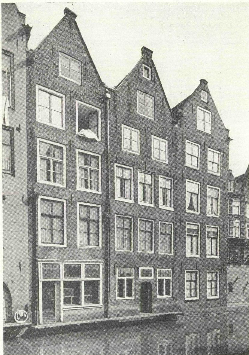
Afb. 1. De karakteristieke achtergevels van de huizen Donkere Gaard 9-11. (Foto Rijksdienst Monumentenzorg)
