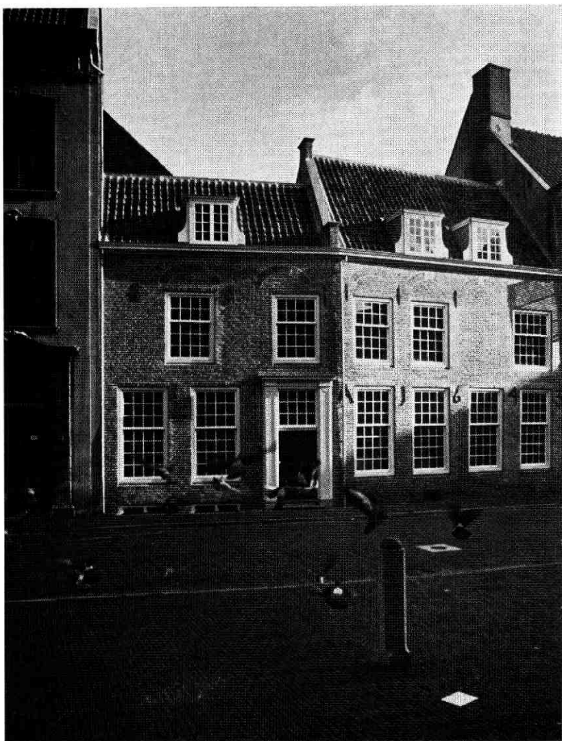
Achter de Dom 16-18 na de restauratie
