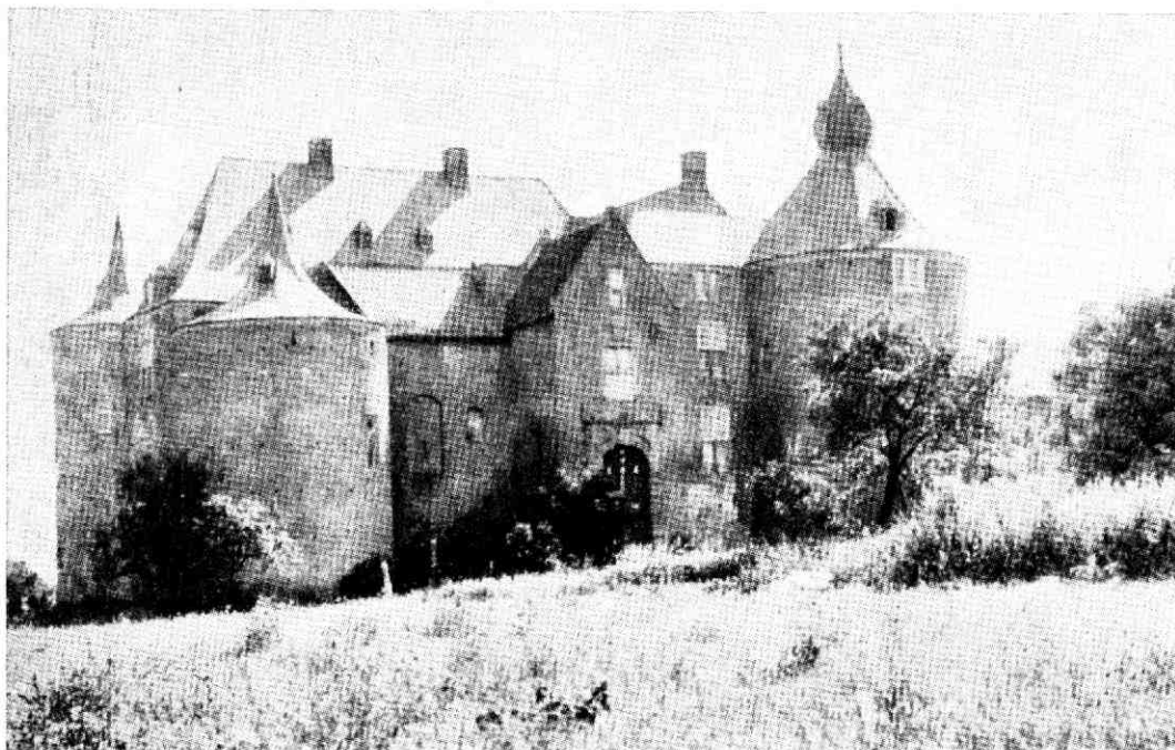
Voorgevel van kasteel Ammersoyen, vóór de restauratie
