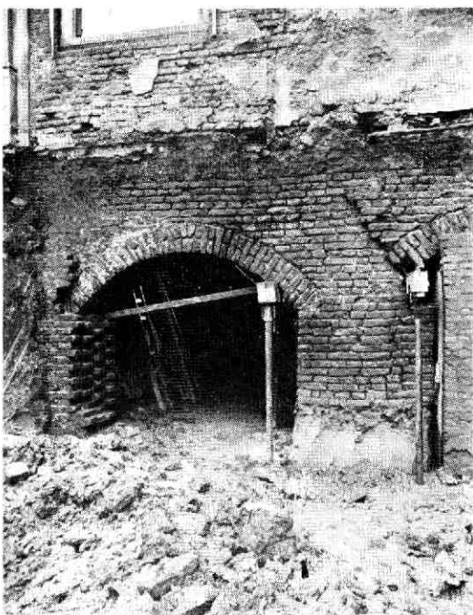
Afb. 1. De muur links van de boog eindigt in een zog. staande tand.
