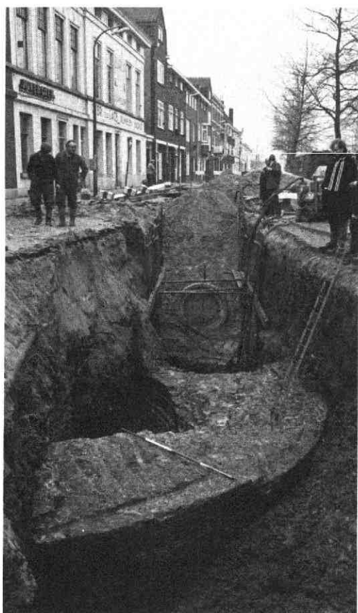
Afb 12. Van Asch van Wijckskade. Wand van de Wolleweverstoren. De bovenste 13 lagen aan de buitenkant zijn beklapt met 17e eeuwse stenen.
