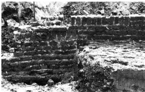
Afb. 124 Vissersplein e.o. De fundering van de poort aan de zuidkant van de Holle Bilt, gezien naar het zuidoosten. Links de rollaag van de oudste poort, rechts daarvan, iets hoger gelegen, de rollaag van de jongere poort. Rechts is nog een restant van het plateau behorend bij de oudste poort te zien.
