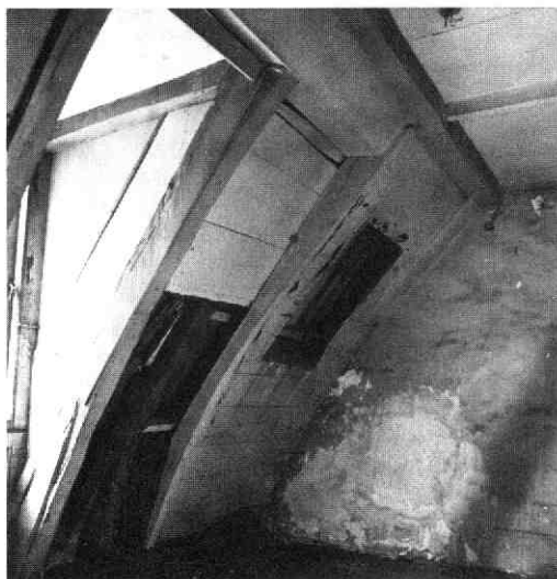
Afb. 16 Brigittenstraat 1-9. Gedeelte van het houten tongewelf van de voormalige Driekoningenkapel in Brigittenstraat 5.
