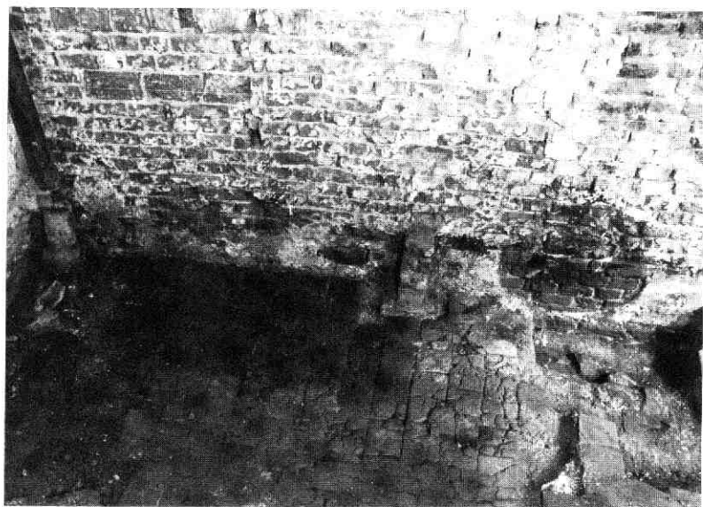
Afb. 109 Springweg 130-130bis. Twee stookplaatsen tegen de zuidwand van het voorhuis. Links op de vloer en tegen de wand een donkere verkleuring van de haard uit het begin van de 16e eeuw. Rechts: de ingebrande „bol” van de haard van 1583.
