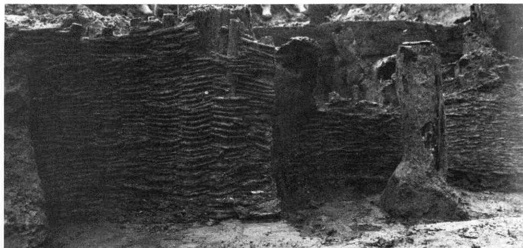
Afb. 29 Jan Meijenstraat e.o. Beschoeiing van vlechtwerk gezien naar het noorden, dus naar de rivier toe. Duidelijk is te zien hoe het rechter gedeelte door grondruk (en onderspoeling?) verder naar de rivier is gezakt dan het linker gedeelte.
