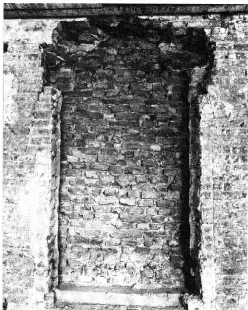
Afb. 17 Brigittenstraat 1-9. Het in 1603 tot deur verbouwde kerkvenster in Brigittenstraat 5, dat in 1636 - gedeeltelijk met profielstenen - weer dichtgemaakt werd.
