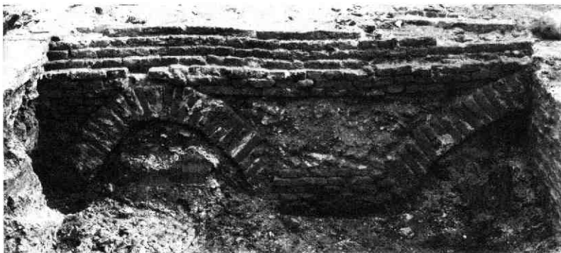
Afb. 119 Vissersplein e.o. De zuidelijke fundering van het huis XI naar het zuiden, met de twee bouwperiodes. De twee grondbogen behoren tot de oudste, de over de bogen gelegen muur bij de jongere periode.
