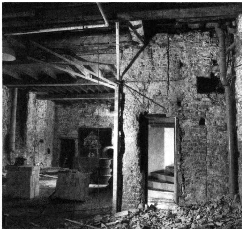
Afb. 65 Jeruzalemstraat 8-10. Begane- grond met doorkijk van de voorvleugel naar de achtervleugel en de spil- trap. Boven de doorgang van de spiltrap is de oor- spronkelijke hoek van een kruisvenster te zien, dat - bij het plaatsen van de trap tijdens bouwfase twee - ongeveer gehal- veerd werd. Achterin: de muurkasten die in de plaats kwamen van de vroegere keuken- schouw. Geheel links: de plaats van de 17e- eeuwse schouw.
