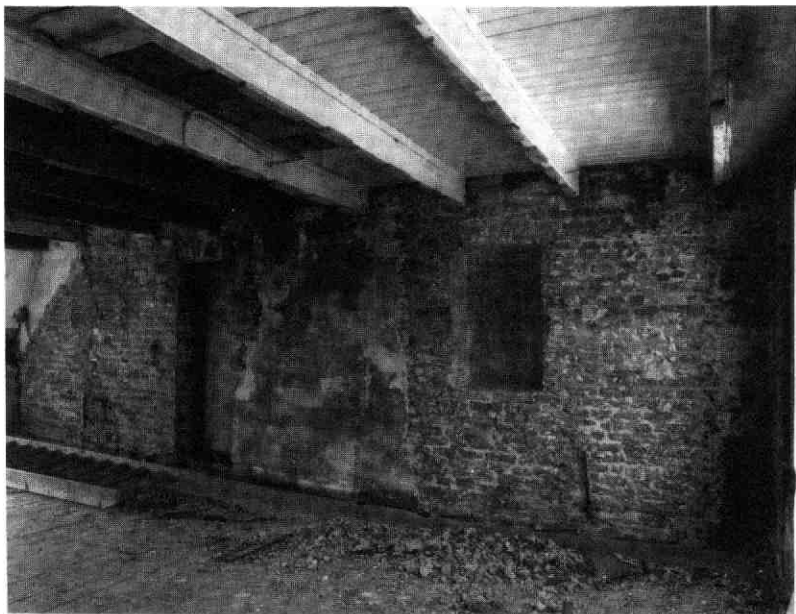
Afb. 48 Geertestraat 26 en 28. De tweede verdieping van nr 28 gezien naar het westen. Rechts de afgehakte strook metselwerk van de middeleeuwse voorgevel. Ter weerszijden van het dichtgemetselde rookkanaal: 14e-eeuwse nissen waarvan de linker later is verdiept. Geheel links is de lijn van het oorspronkelijke achterdakvlak te volgen.
