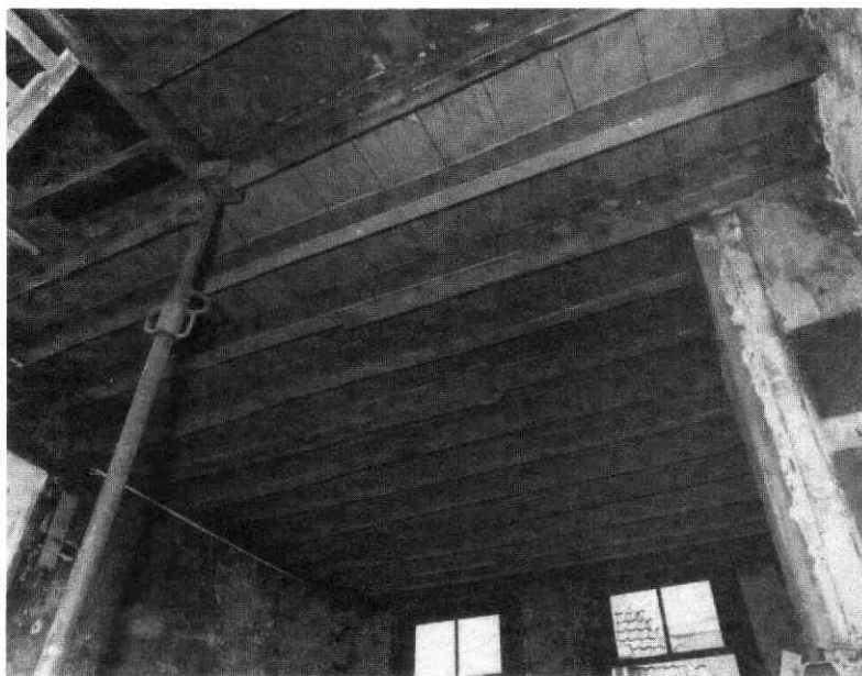
Afb. 44 Geertestraat 26 en 28. De 14e-eeuwse balklaag van de verdieping: eiken en den-
