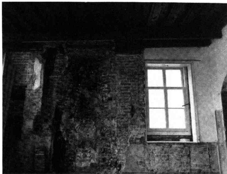
Afb. 56 Jeruzalem- straat 8-10. De noord- westmuur op de verdie- ping ter plaatse van de oorspronkelijke trapra- veling. Rechtsboven ver- tonen de kinderbinten een onderbreking. In het midden: sporen van een oorspronkelijke haard.
