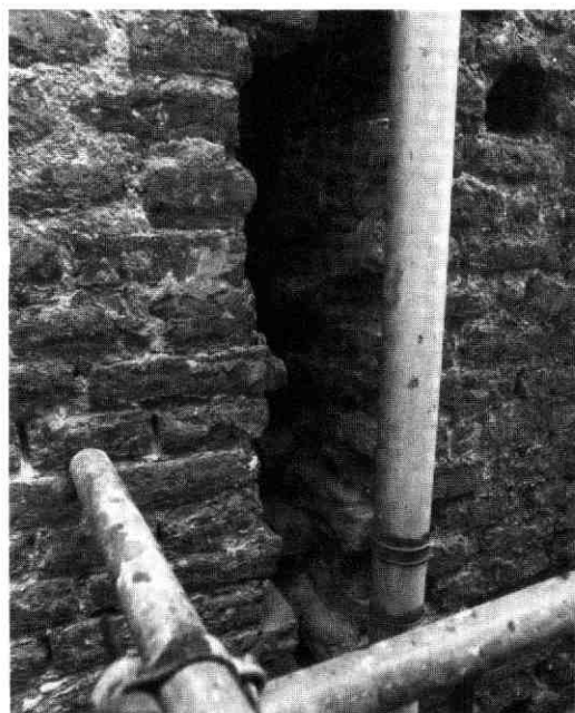
Afb. 62 Jeruzalemstraat 8-10. Detail van de noord- westgevel met de spleet tussen de voor- en achter- vleugel. De vertanding van de vroegere hoek van de voorvleugel is duidelijk te zien.
