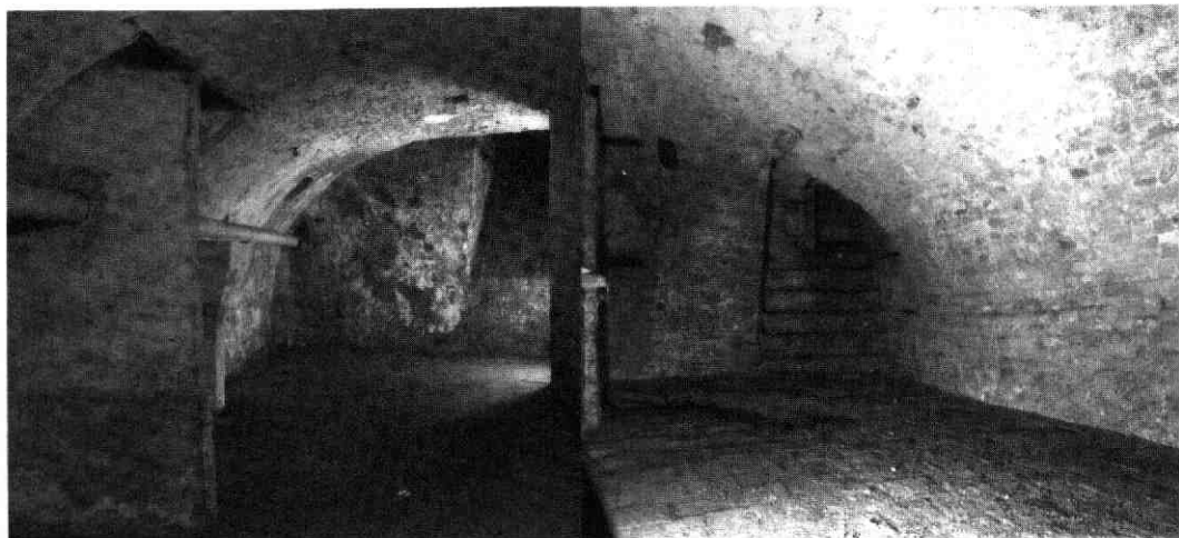
Afb. 162 Springweg 67. Montagefoto van de in de lengte opgedeelde kelder onder de vroegere voorzaal. Rechts de trap naar de straat. Links de plaats van de binnentrap.
