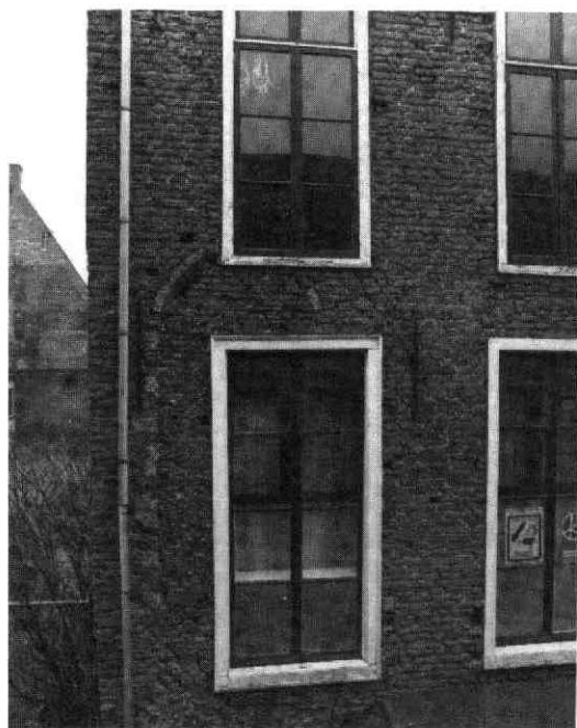
Afb. 52 Jeruzalemstraat 8-10. Detail van de voor-gevel met de dichtgemetselde en doorbroken spitsboognis van de oorspronkelijke ingang. In de zandsteenblokken zijn in het einde van de 16e eeuw schijnvoegen gehakt.
