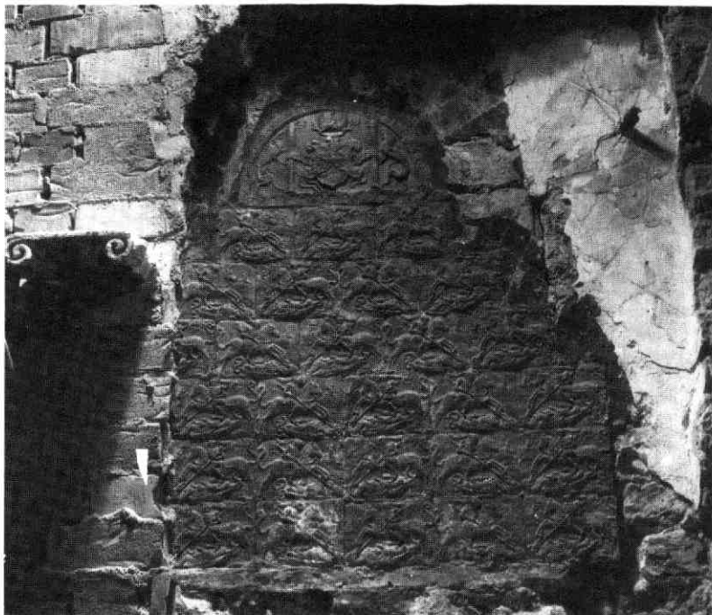
Afb. 189 Twijnstraat 50. De haard van de insteekverdieping aan de noordzijde. Links het teruggevonden bakstenen kapiteeltje van een wangpilaster.
