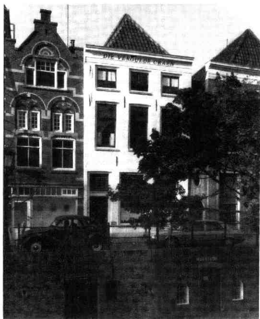
Afb. 113 Oude Gracht 17. Voorgevel na de restauratie.
