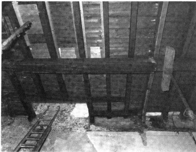
Afb. 43 Geertestraat 26 en 28. De 14e-eeuwse, eiken balklaag boven de beganegrond met gotische sleutelstukken en de raveling van de verdwenen schouw. Daarvóór de raveling van een stookgewelfje. De onderslagbalk is van omstreeks 1600.
