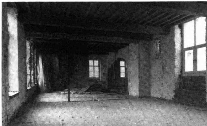
Afb. 66 Jeruzalem-straat 8-10. De verdieping van de oudste vleugel. Onder de moerbalk vóór het kleine venstertje is een ondiepe sleuf zichtbaar: het is de plaats van de oorspronkelijke dwarsmuur. Achterin: de 19e-eeuwse, grote opening naar de achtervleugel.
