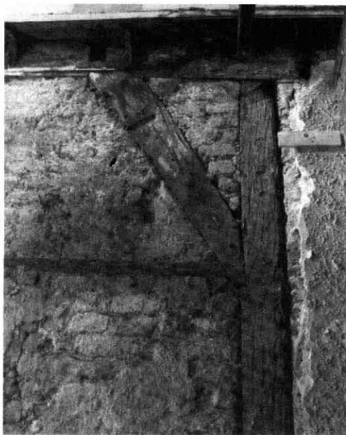
Afb. 37 Geertestraat 14-16. De vakwerkconstructie in de muur tussen nr 14 en nr 16 (achterste deel).
