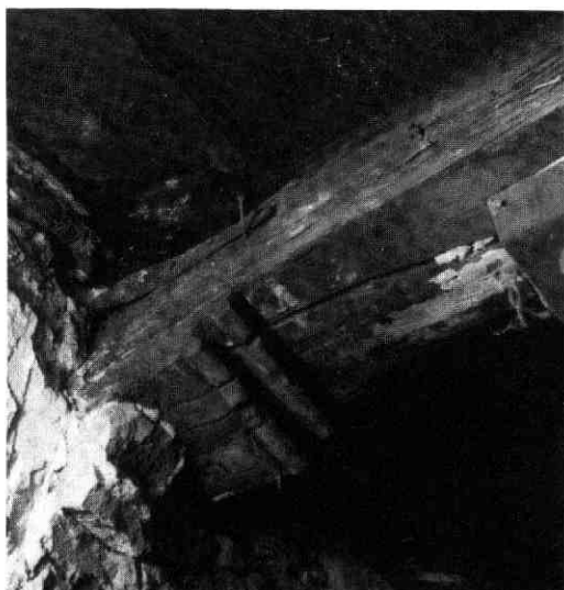
Afb. 201 Zwaansteeg 2 en 4. Moerbalk met 15e-eeuws sleutelstuk in Zwaansteeg 2.
