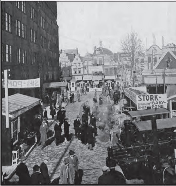
Gezicht op het terrein van de beurs op het Vredenburg voor het vaste Jaarbeursgebouw
