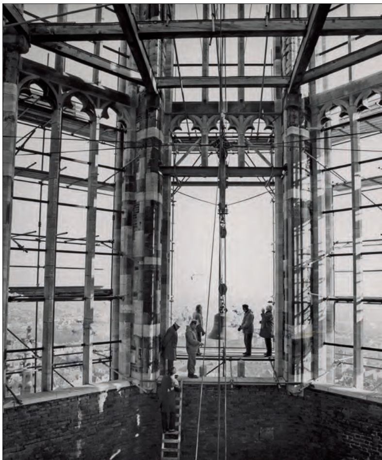
Het verwijderen van de voor de restauratie bestemde klokken van de Domtoren in 1974.
