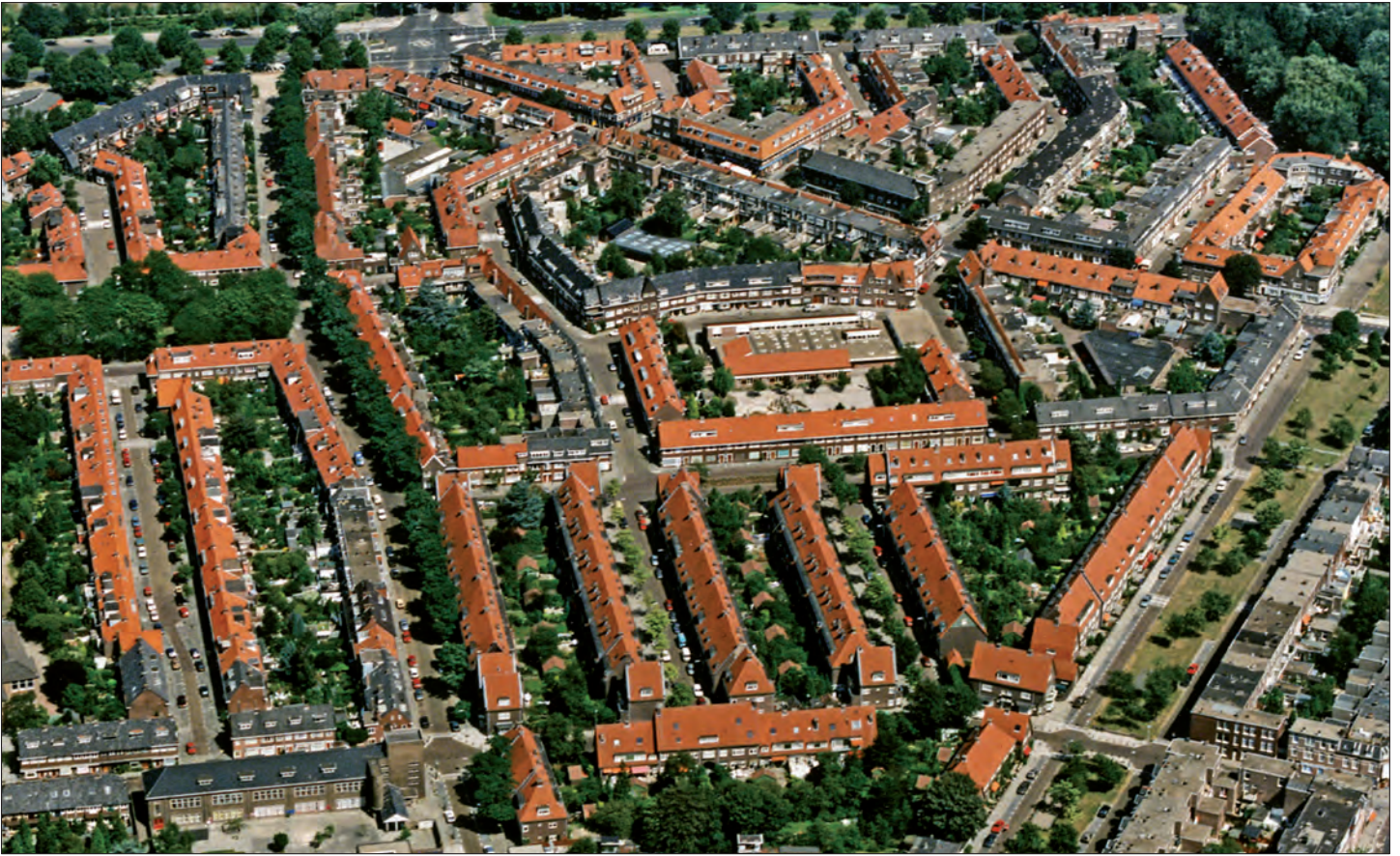
Luchtfoto Tuinwijk vanuit het zuidwesten.
