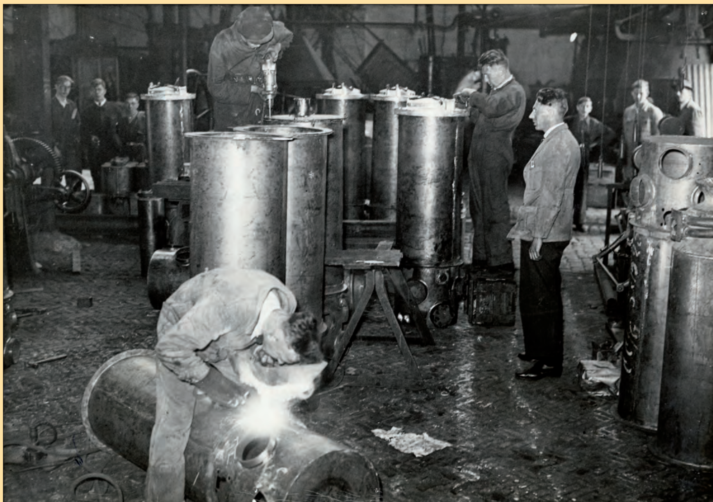
De arbeiders van de machinefabriek Jaffa sloten zich snel bij de staking aan. De foto toont de vervaardiging van houtgasgeneratoren in 1940.
