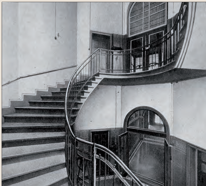
Oorspronkelijk trappenhuis, ca 1910
