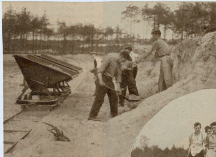
Het zand wordt van heuvels in het bosch achter den Stuijtheuvel gelegen, afgegraven en in kip-lorrie's per rail naar de plaats van bestemming vervoerd.
