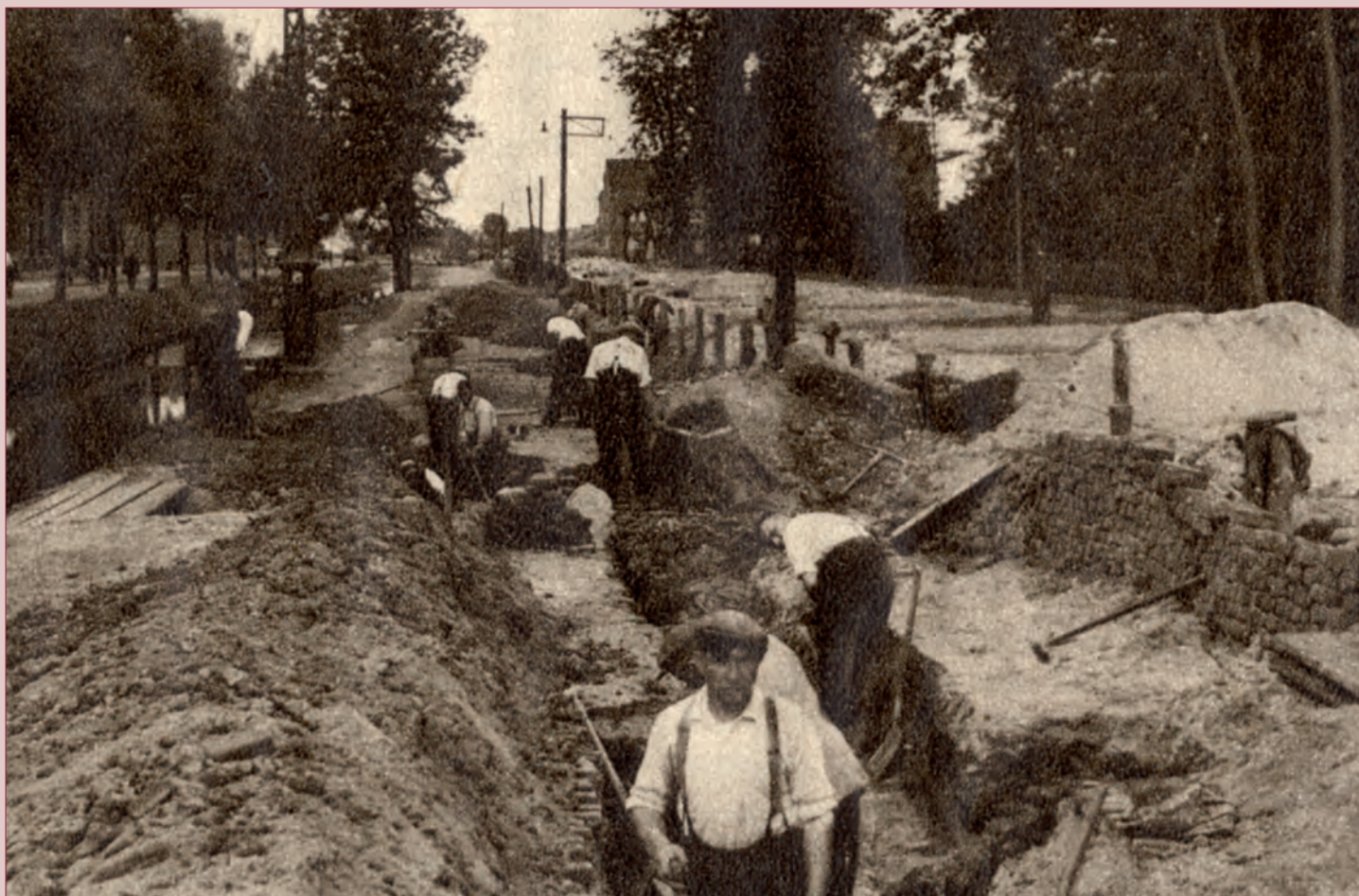
De demping van de Vleutensche Wetering (nog te zien links op de foto) tussen de Billitonkade en de Steenovenweg werd in de jaren dertig in twee fasen uitgevoerd. Een deel van het werk werd niet langer door machines, maar door werklozen gedaan. Foto uit ca. 1934.
