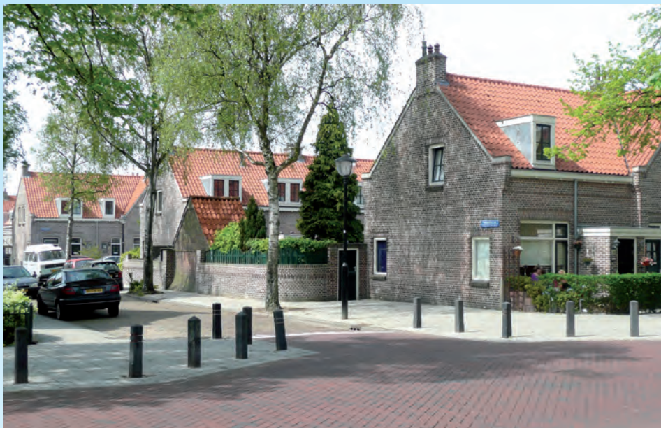
Daalsedijkroute: hoek Marconistraat / Edisonstraat met woningen behorend tot de 'Oude Bouw', een wijkje door Ph.J. Hamers ontworpen voor de Woningbouwvereniging Zuilen.
