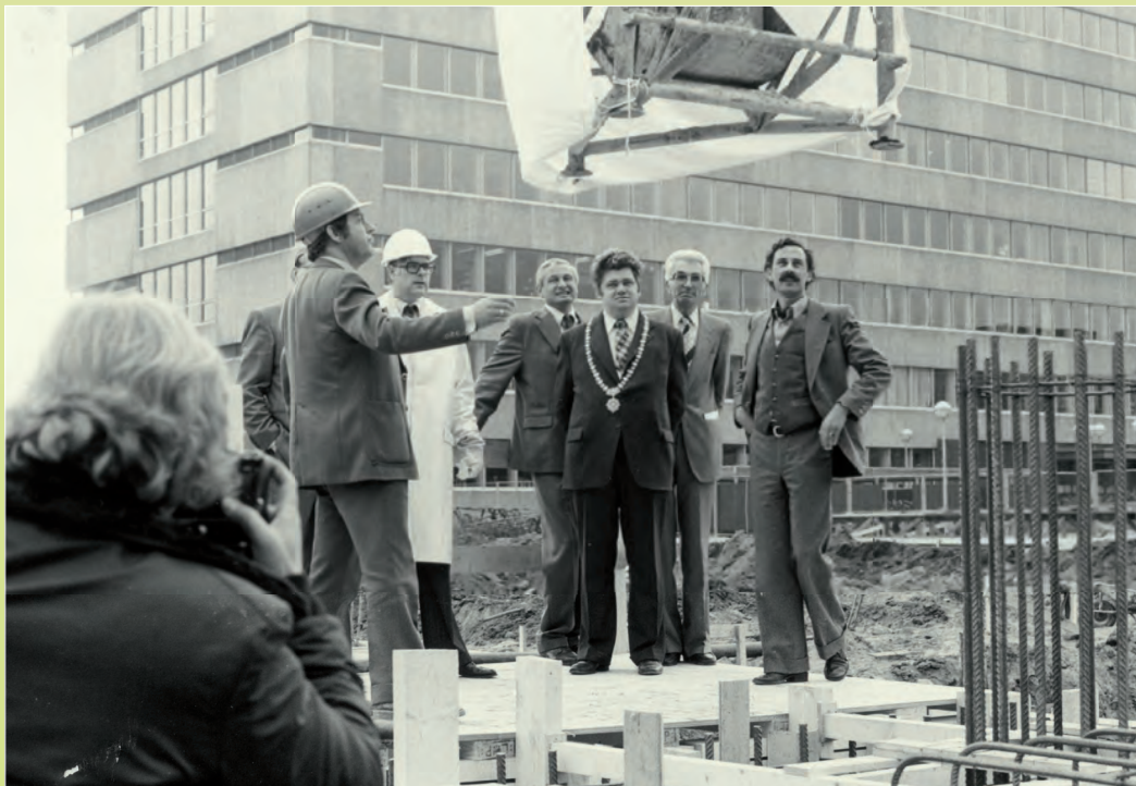
Plechtigheid (storten eerste beton?) met burgemeester Vonhoff voor het gebouw van aardwetenschappen op 22 september 1977.
