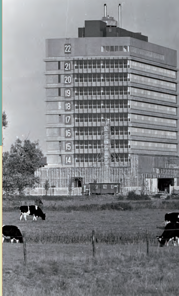
Trans II in aanbouw, oktober 1968. De bovenste negen verdiepingen zijn voltooid.
