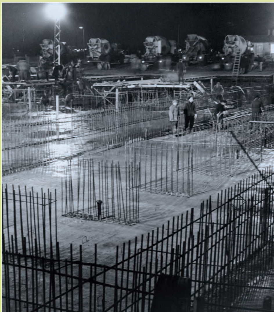
Nachtelijke werkzaamheden voor de bouw van Trans 2, 1965.
