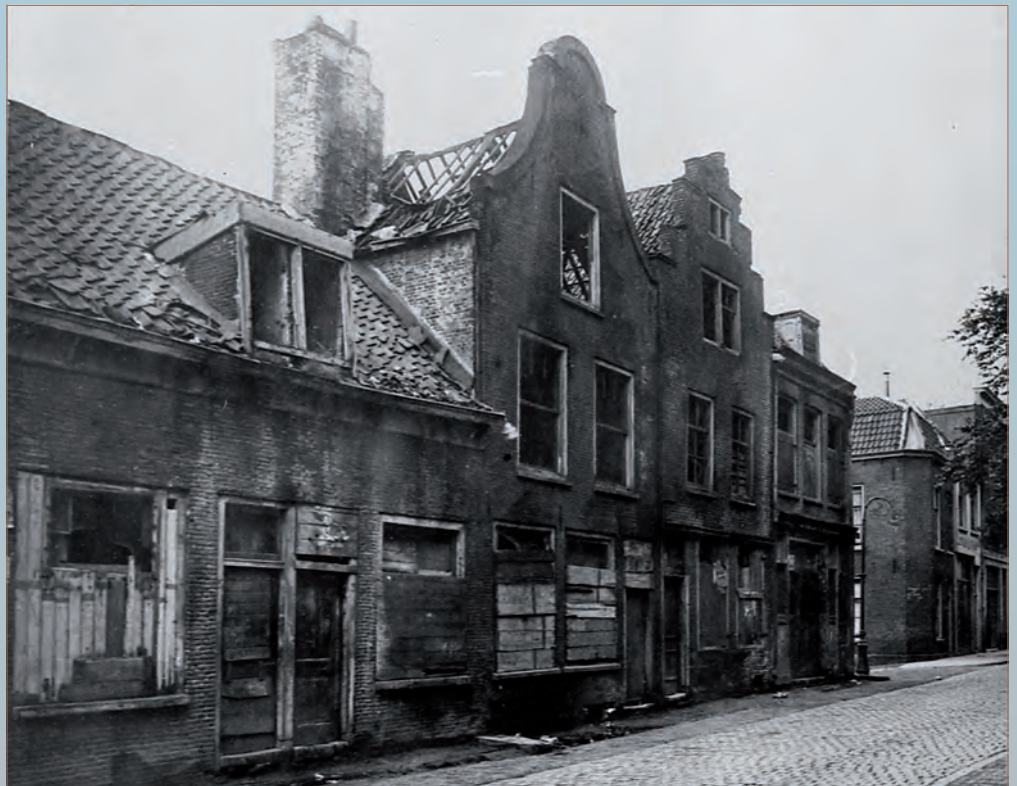
Krotten, Waterstraat 15-23, met rechts de ingang van de Jan Meijenstraat, 1926.
