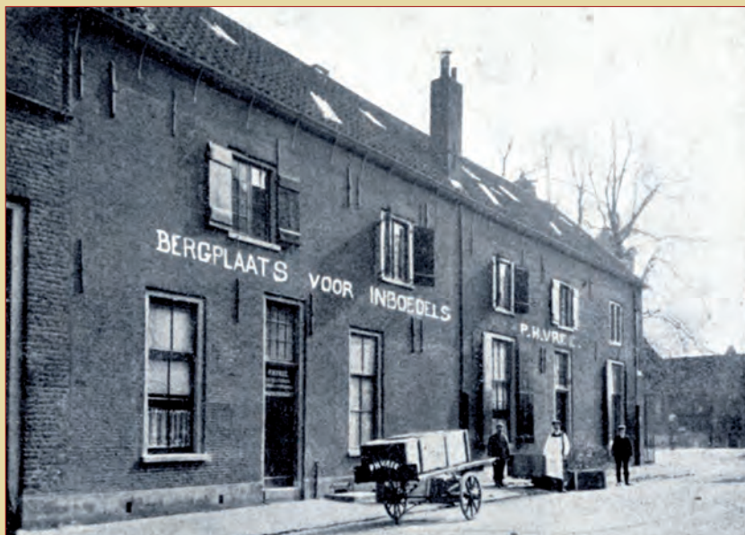
Gezicht op enkele huizen van het Agnietenklooster in de Agnietenstraat rond 1908. Deze huizen moesten wijken voor het nieuwe gebouw van het Centraal Museum.
