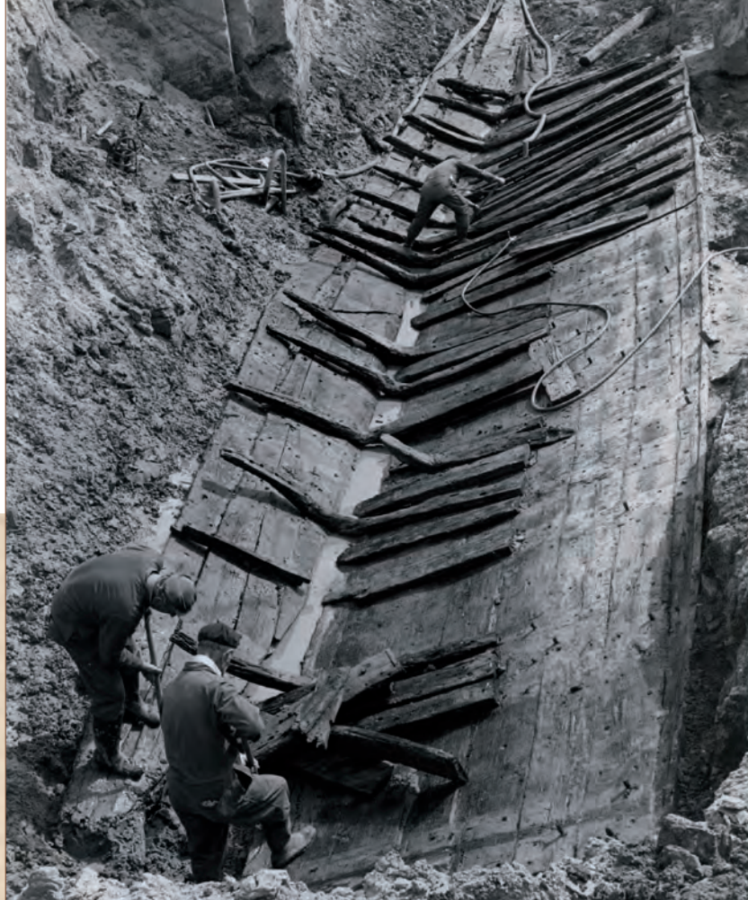
Een groot platboomvaartuig is gevonden in de bouwput van de Nederlandsche Bank aan de Waterstraat in Wijk C. Het schip is over een lengte van ruim 22 meter bewaard gebleven. Het gehele schip is met houten pennen in elkaar gezet.
