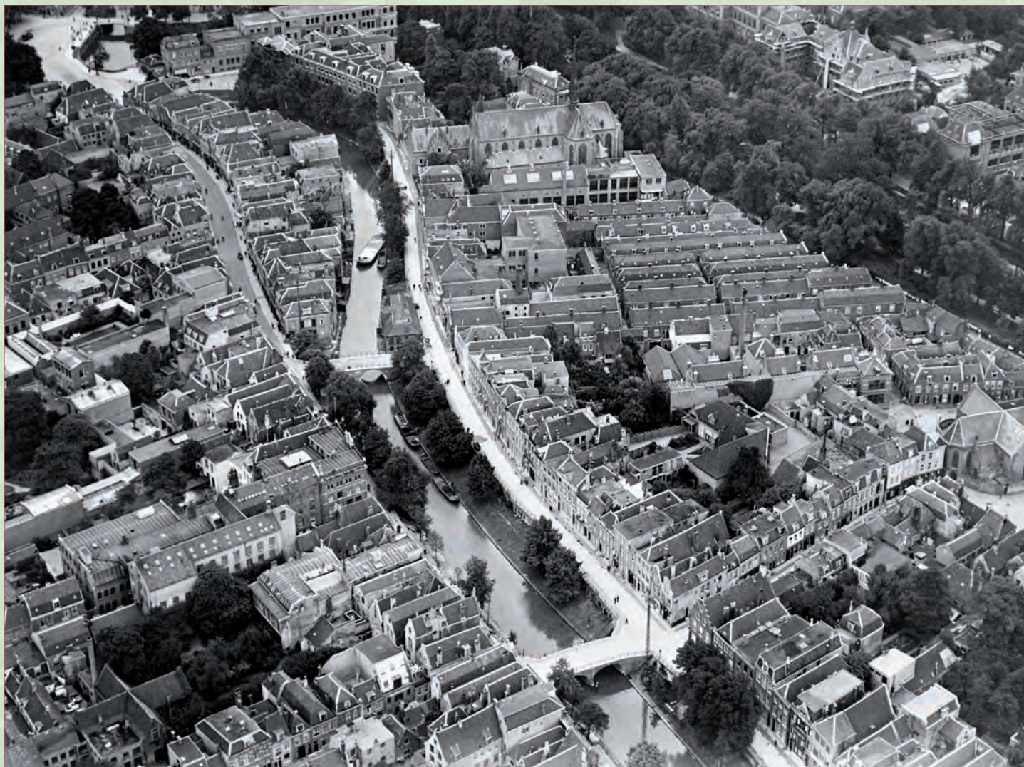
Luchtfoto (uitsnede) uit 1927. De Twijnstraat vanuit het zuiden, beginnend bij de duidelijk zichtbare Voldersbrug. Rechts de Oudegracht. Goed te zien is dat de straat in het midden breder is dan aan de uiteinden en dat het eerste deel van de werf verdeeld is in verschillende erven met bijgebouwtjes.
