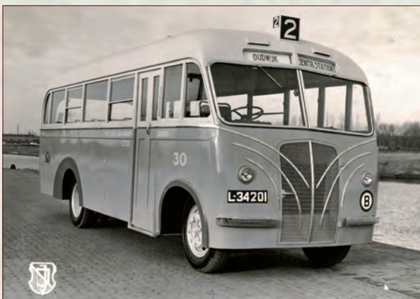
De autobus op een Bedfordchassis, die werd gemaakt bij Jongerius. De opdracht was door het gemeentelijke vervoerbedrijf in eerste instantie bij bussenbouwer Hoogeveen geplaatst, maar die kon niet op tijd leveren. Deze bus werd op 24 januari 1947 in gebruik genomen en had 31 zitplaatsen en 14 staanplaatsen.
