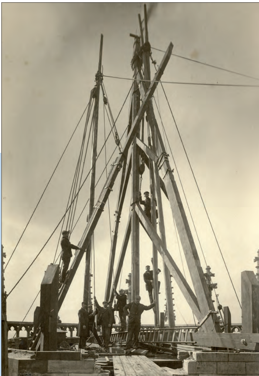
Werklieden bezig met de bouw van de nieuwe kap van de lantaarn, april 1910.
