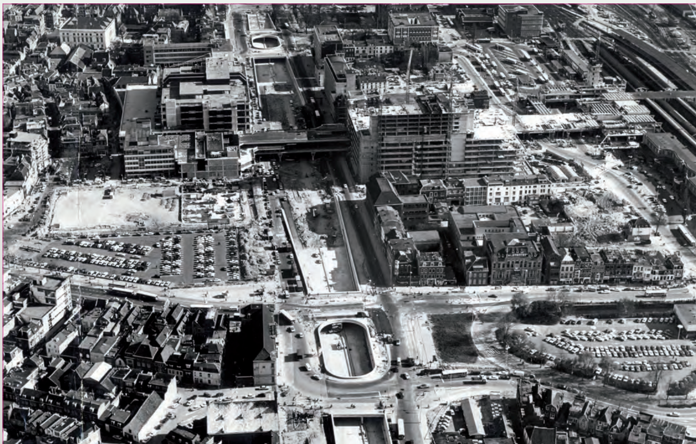
Luchtfoto van het stationsgebied met de Catharijnebaan en Hoog Catharijne in aanbouw, 1970. Links is het Vredenburg met geparkeerde auto's te zien. De Jaarbeursgebouwen daar zijn net gesloopt. Rechts is nog een deel van de oude stationswijk te zien met het Jugendstilgebouw van verzekeringsmaatschappij 'De Utrecht'.
