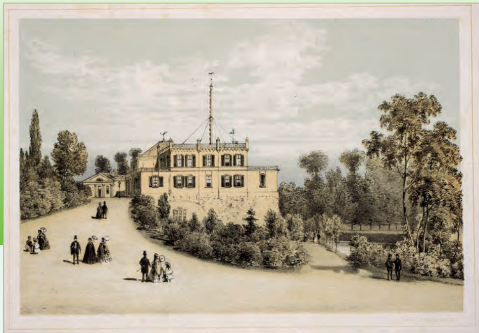
Gezicht op de gebouwen van het Meteorologisch Instituut op het voormalig bastion Zonnenburg vanuit het zuidwesten.
