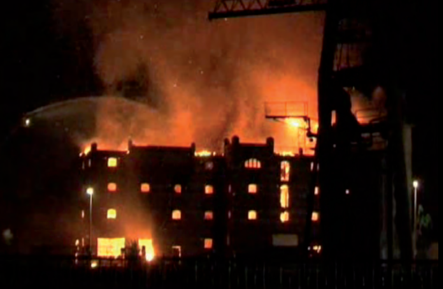
In de nacht van 29 op 30 juni 2008 brandde het Cereol-gebouw uit. Er werd direct gedacht aan brandstichting.
