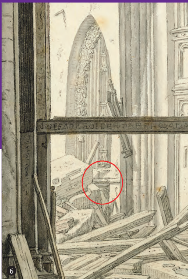
De doorgang naar het noordportaal vanuit het schip na instorting van het schip in 1674. In de rode cirkel is net boven het puin uit een glimp te zien van de latei boven de deuren in deze doorgang. Detail van een tekening van Herman Saffleven, 1674.
