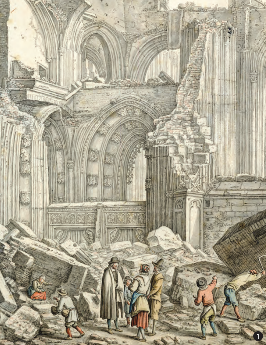
Noordportaal van de Dom na instorting van het schip in 1674. Beide lateien zijn nog duidelijk zichtbaar, de rechter is behouden. Uitsnede uit een tekening van Herman Saftleven, 1674.
