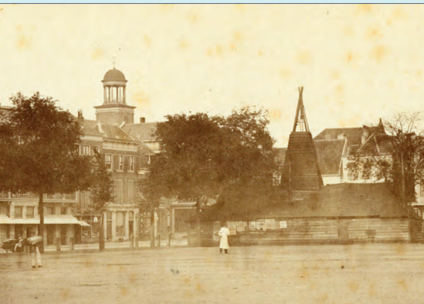
De met een houten keet ombouwde boorinstallatie op de noordoosthoek van het Vredenburg, 1878.
