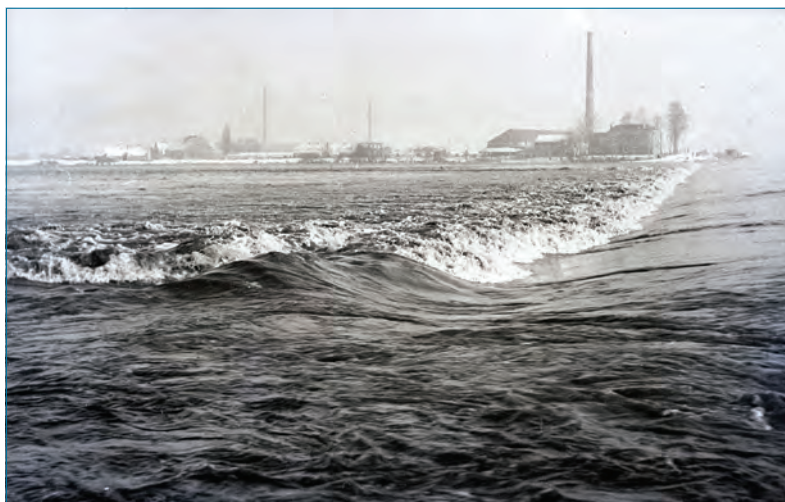
3 De overlaat in de Oude Rijnmond bij Lobith/Tolkamer in 1926. Deze overlaat werd pas in 1959 definitief gesloten. Eerder was dat niet mogelijk als gevolg van verdragen met Pruisen, later Duitsland.
