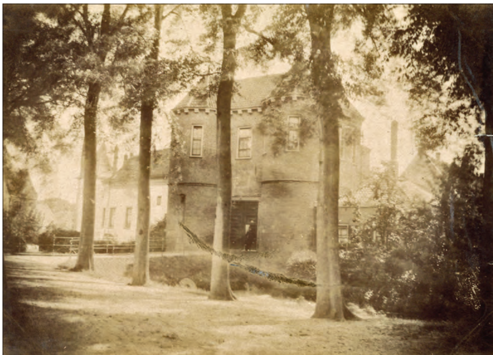
Het poortgebouw van het Kasteel te Montfoort (Om 't Hof) in 1889, toen in gebruik als rijkstuchtschool en opvoedingsgesticht voor meisjes.
