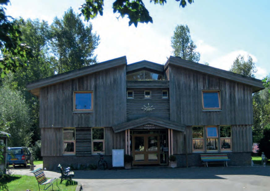
Het in 1996 gebouwde woonhuis en kantoor van Emmaus Haarzuilens.
