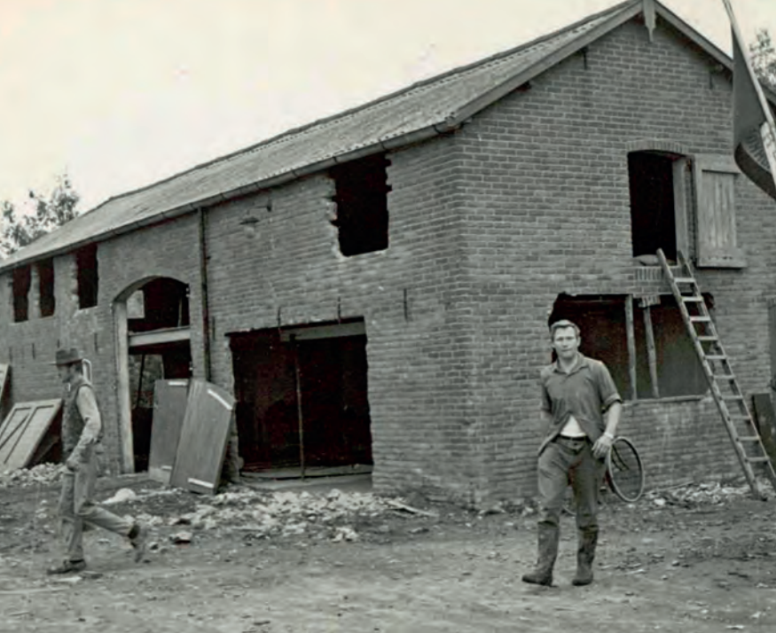
Een van de varkensstallen tijdens de verbouwing, 1967.
