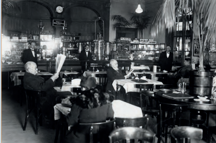
Interieur restauratiezaal 1e en 2e klasse, 1936.
