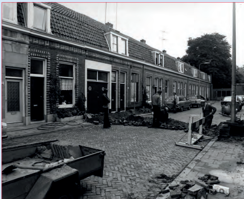
In 1980 worden de huizen in de Tulppstraat in Utrecht aangesloten op kabeltelevisie. Twee jaar later is de bekabeling van de hele stad klaar.
