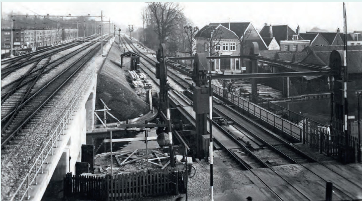
De hulpspoorbaan en de hefbrug over de Vaartsche Rijn ter hoogte van de halte Jeremiebrug. Links de verhoogde spoorbanen naar Den Bosch en Arnhem ca 1937-38. Op de voorgrond rechts de (tijdelijke) spoorwegovergang op de Westerkade. De voetgangerstunnel was al gesloten.
