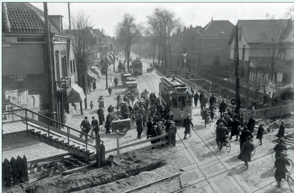
Begin van de aanleg voetgangerstunnel Amsterdamsestraatweg ca 1924.
