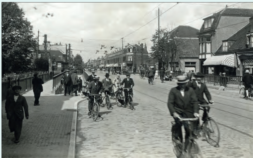
Spoorwegovergang met voetgangerstunnels op de Amsterdamsestraatweg 1930. Niet alle fietsers maakten gebruik van de tunnel.
