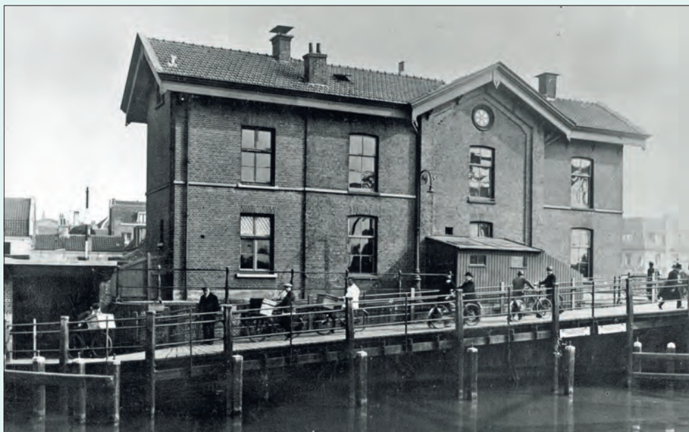
Opgang vanuit de tunnel naar de Jeremiebrug met het Staatsspoor-dienstgebouw (later brugwachterswoning spoorbruggen Vaartsche Rijn) begin jaren 30.
