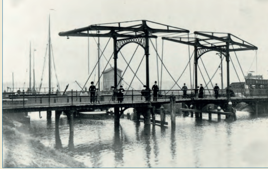
Door de Utrechtsche IJzergieterij in 1866 opgeleverde ophaalbrug over de Mark in Breda. De brug maakte in 1893 plaats voor een spoorbrug.
