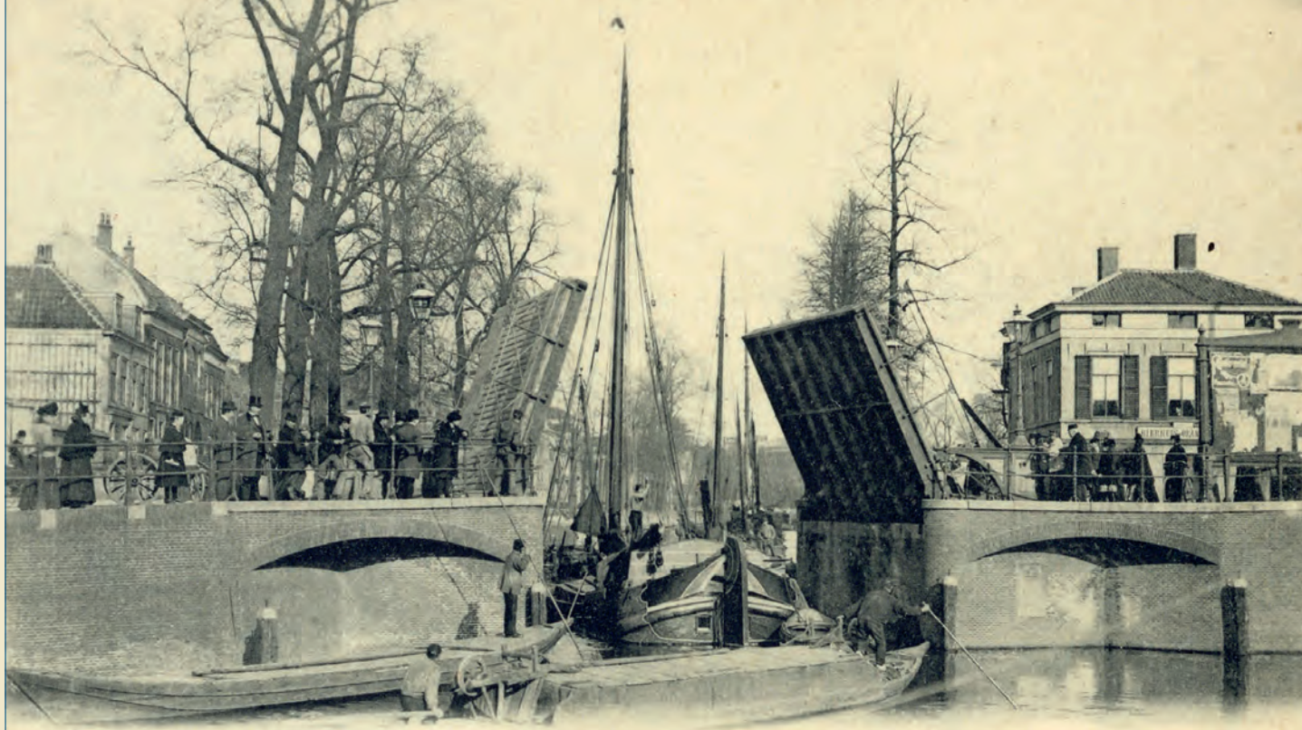
De door de Utrechtsche IJzergieterij vervaardigde basculebrug over de Stadsbuitengracht rond 1900. De gieterij lag slechts enkele honderden meters verderop.
